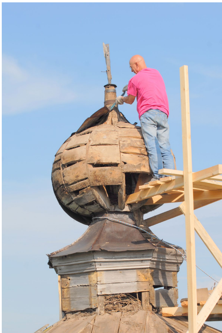
Илл. 16. Главка. Тип покрытия лежачий одинарный фальц чёрного железа. Фиксация журавцов главки к барабану XVIII в. Стропила и прогоны конструкции юбки XIX в.
