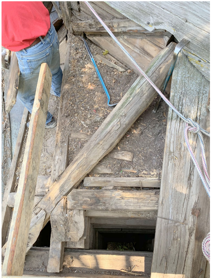
Илл. 39. Штроба под тес и гнездо под стропило. Юго-восточный зауголок.
