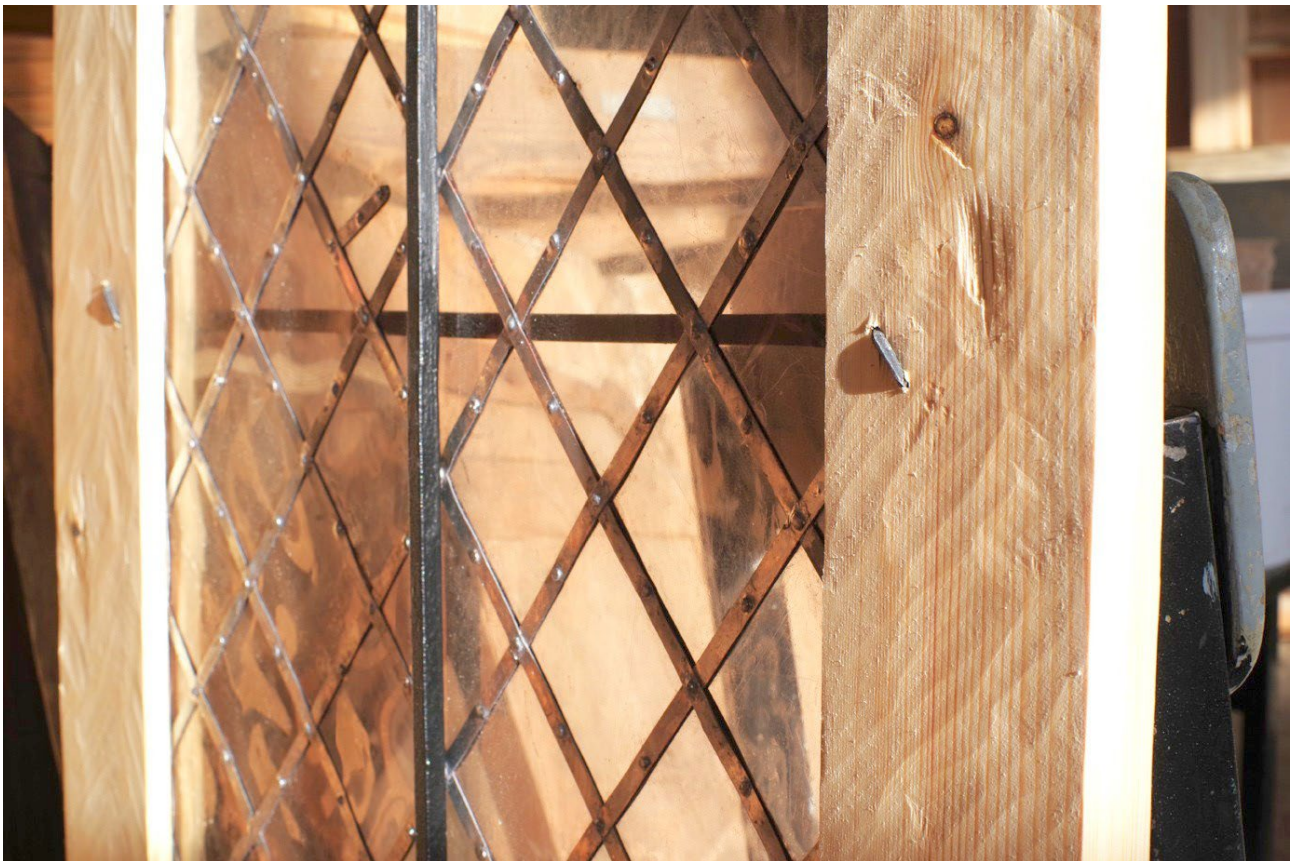
Илл. Д/2. Воссоздание слюдяных оконниц. Характер обработки рамы скобелем.
