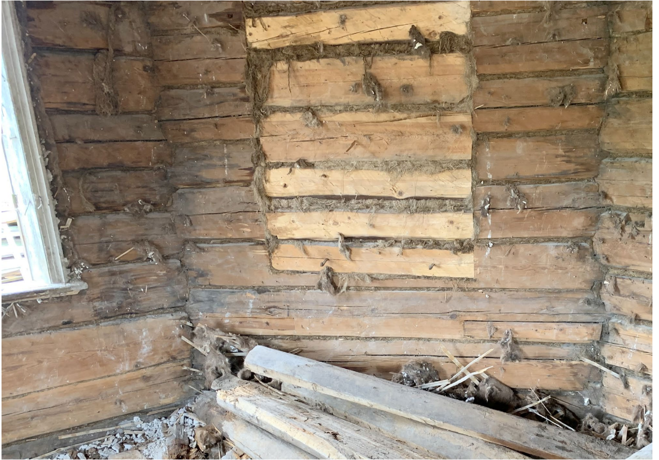
Илл. 133. Следы церковной утвари в объёме алтаря.
