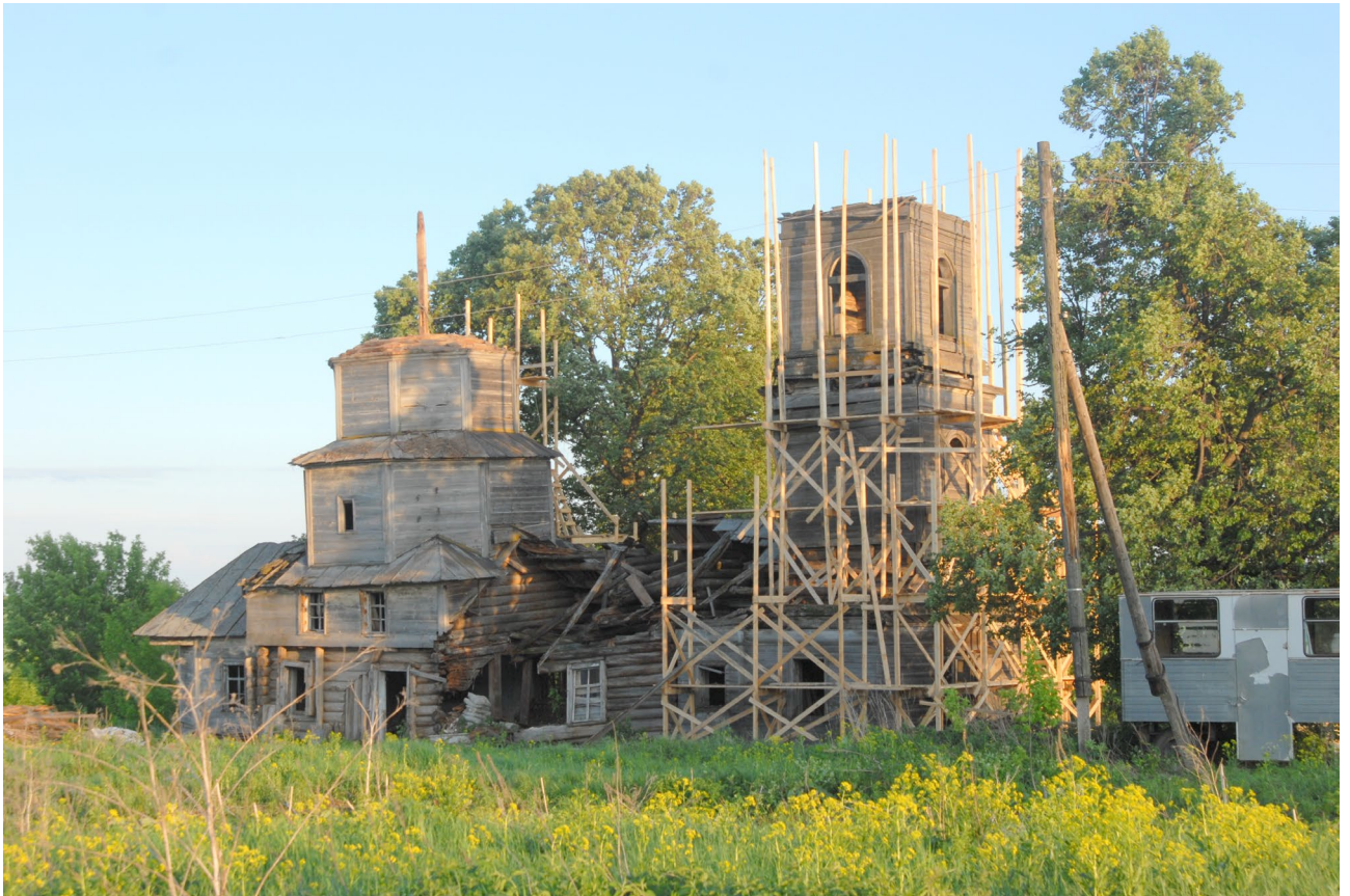
Илл. 27. Вид с северо-востока на стадии разборки стропильной конструкции второго восьмерика и возведения лесов вокруг колокольни.
