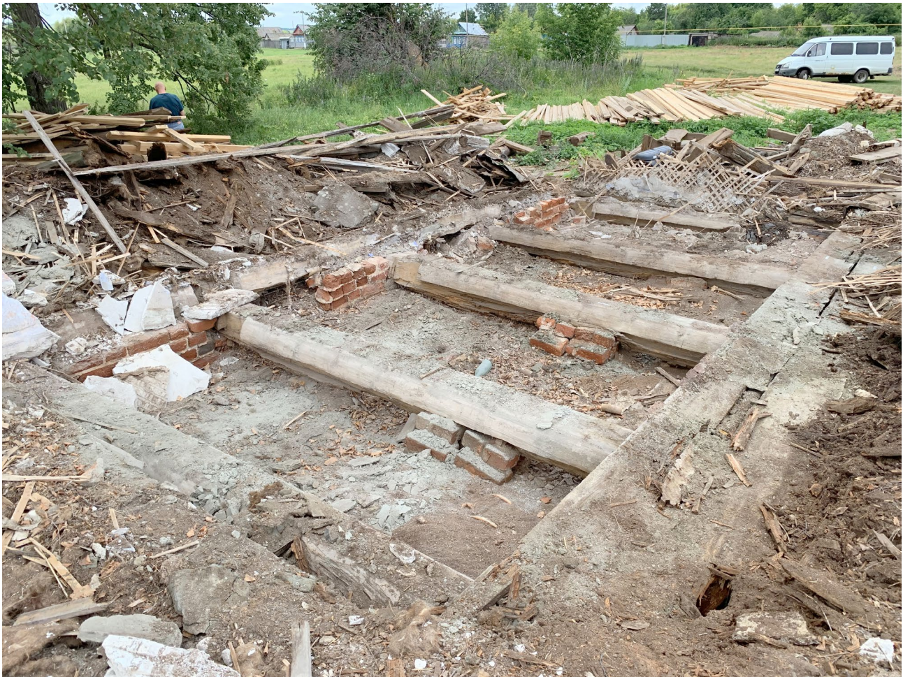
Илл. 141. Балки пола трапезной.
