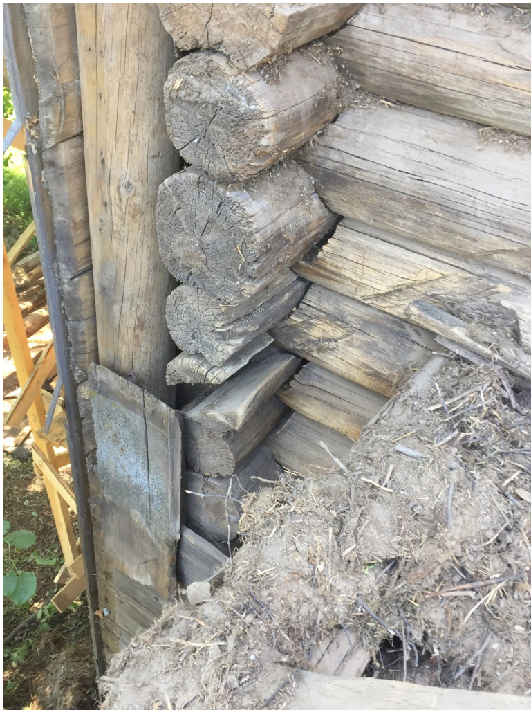
Илл. 45. Паз под тес кровли алтаря в восточной стене кафоликона, захватывающий выпуски южной стены.
