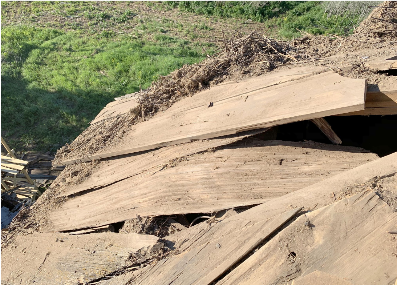
Илл. 25. Устройство конструкции кровли второго восьмерика. Подлинная конструкция XVIII в. , в ремонте XIX в. удалили второй слой дороженого теса.
