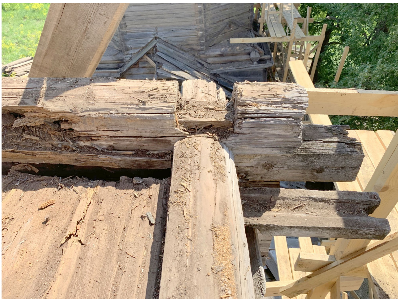
Илл. 72. Конструкция пола яруса звона колокольни. Юго-восточный угол. Вынос желоба водостброса. Вид с запада.
