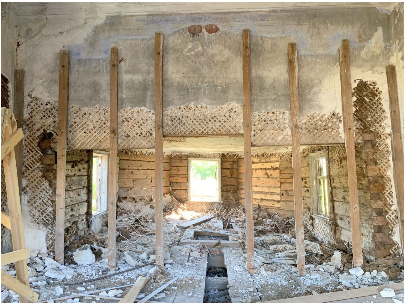
Илл. 114. Снятие войлока и дранки в объёме алтаря. раскрытие волокового окна в интерьере.
