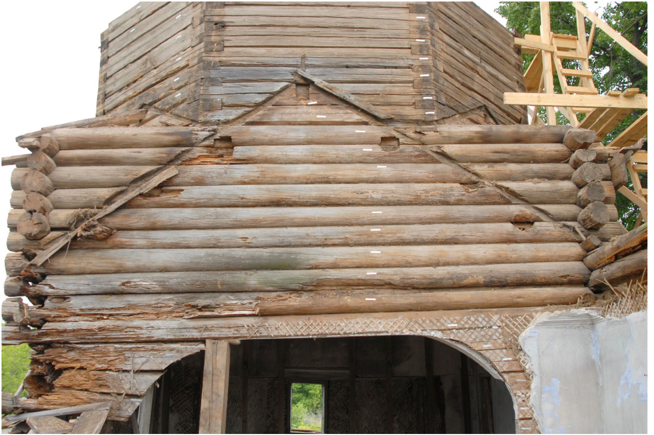
Илл. 107. Гнёзда под слези, штробы под тѣс, след от гребня (конструкций XVIII в.) на западной стене кафоликона и первого восьмерика.
