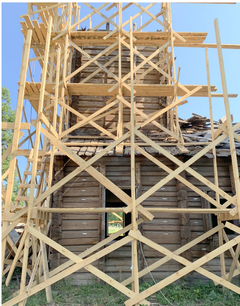
Илл. 71. Разборка конструкций колокольни. Вид с юга.
