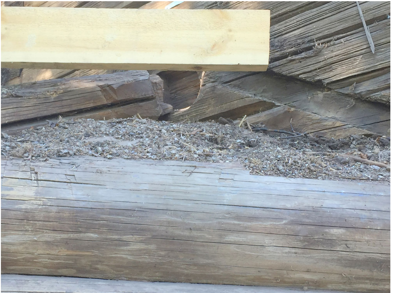
Илл. 137. Гнездо коньковой слепи и штроба под тѣс кровли алтаря XVIII в. в восточной стене кафоликона и первого восьмерика.
