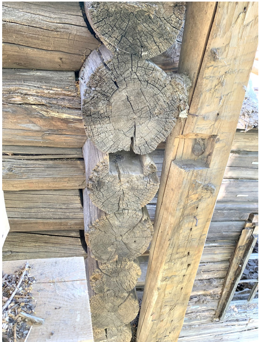
Илл. 146. Гнездо лесов в выпуске восточной сены кафоликона.
