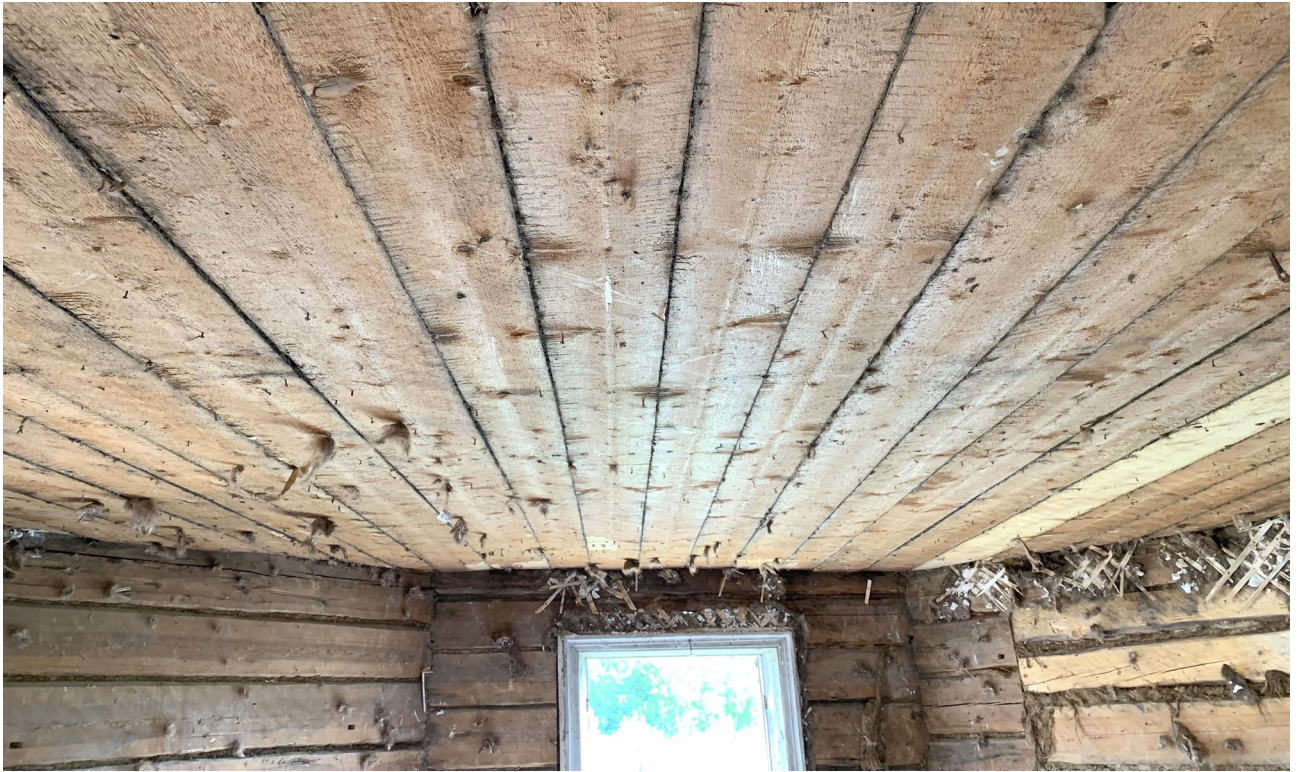
Илл. 125. Подшивка потолка алтаря.
