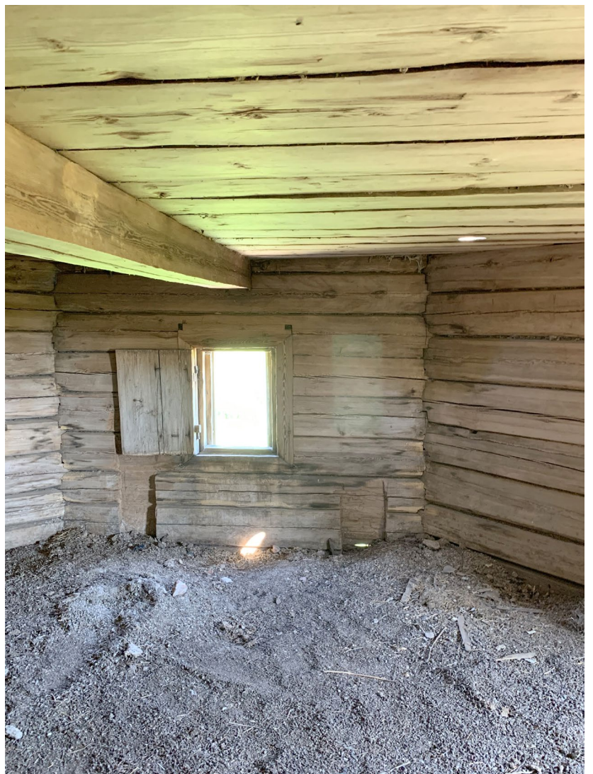
Илл. 142. Штробы заводки балок потолка кафоликона.
