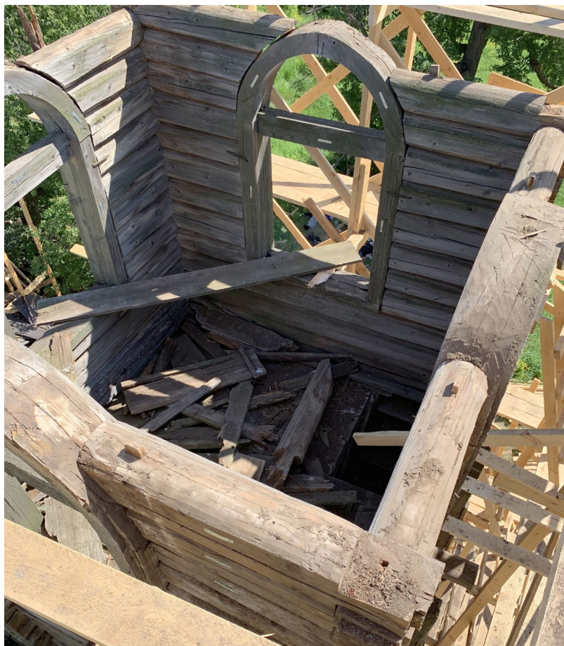
Илл. 66. Разборка конструкций колокольни. След от костыля в лапе.
