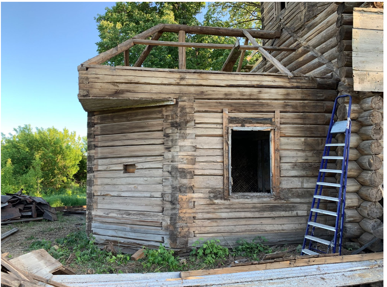
Илл. 50. Вид на алтарь с северо-востока. Волоковое окно. Стропильная конструкция. Характер рубки сруба прямая лапа.
