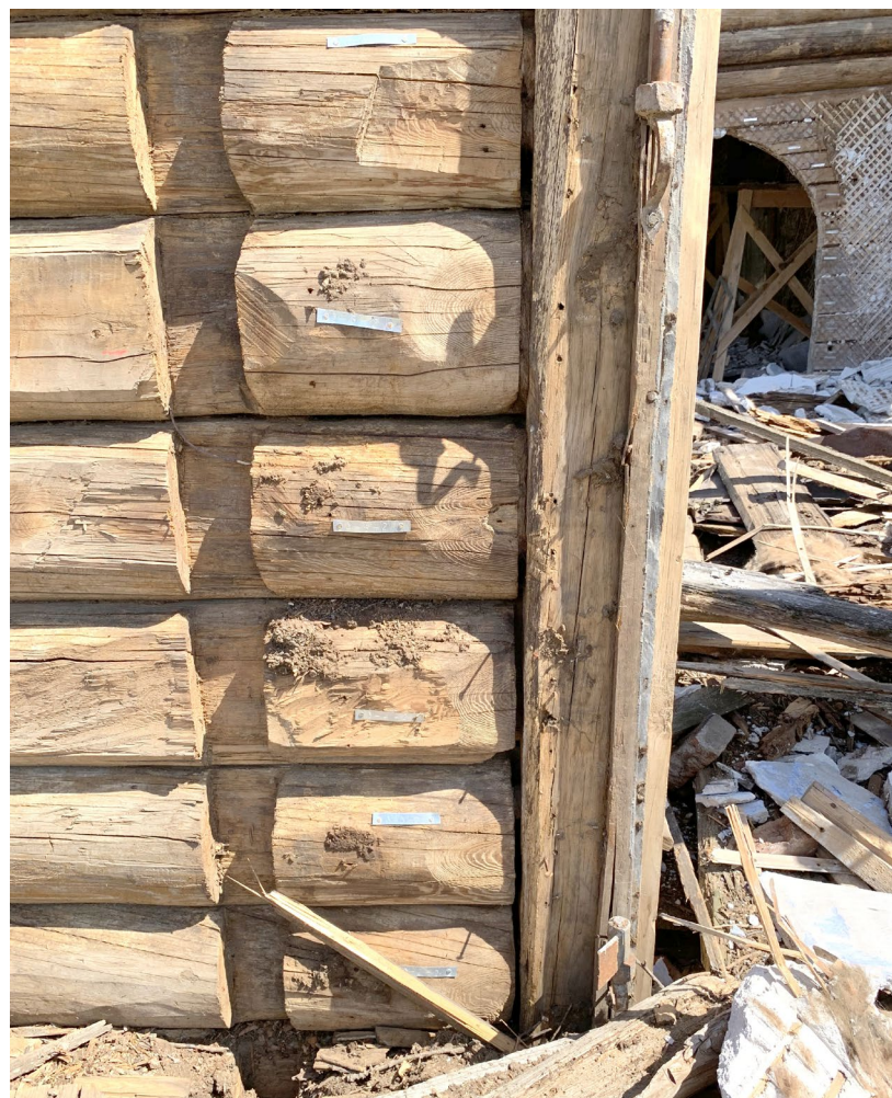
Илл. 148. Затёски дверного проёма XVIII в. Слева от ДВ-1.
