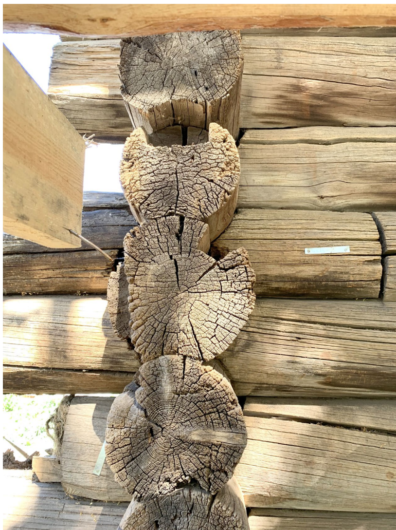
Илл. 147. Гнездо лесов в выпуске западной стены кафоликона.
