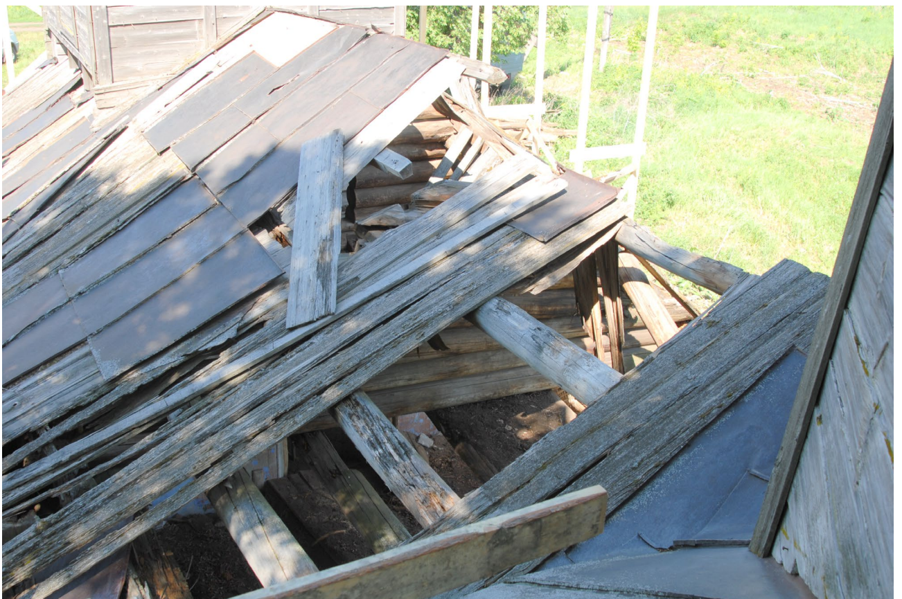
Илл. 84. Конструкция самцово-слезной кровли трапезной.
