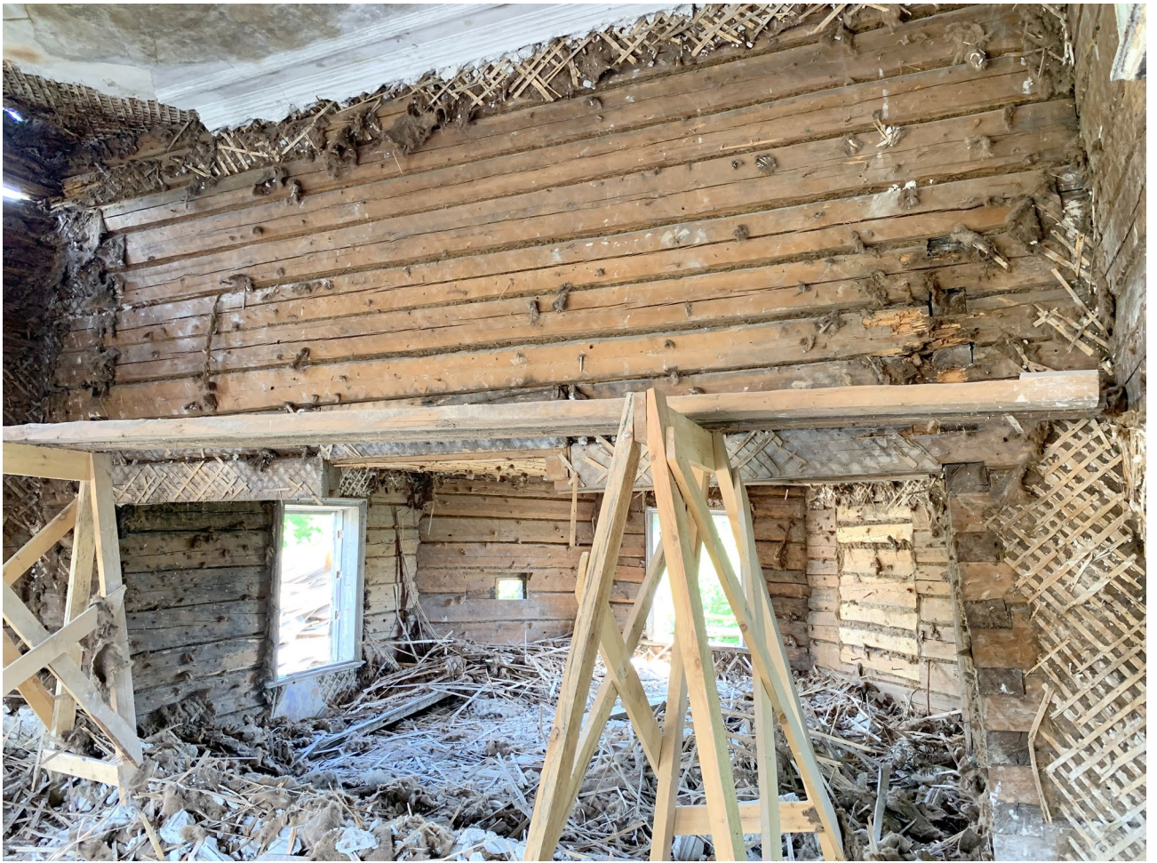
Илл. 121. Снятие дранки и войлока в объёме кафоликона.
