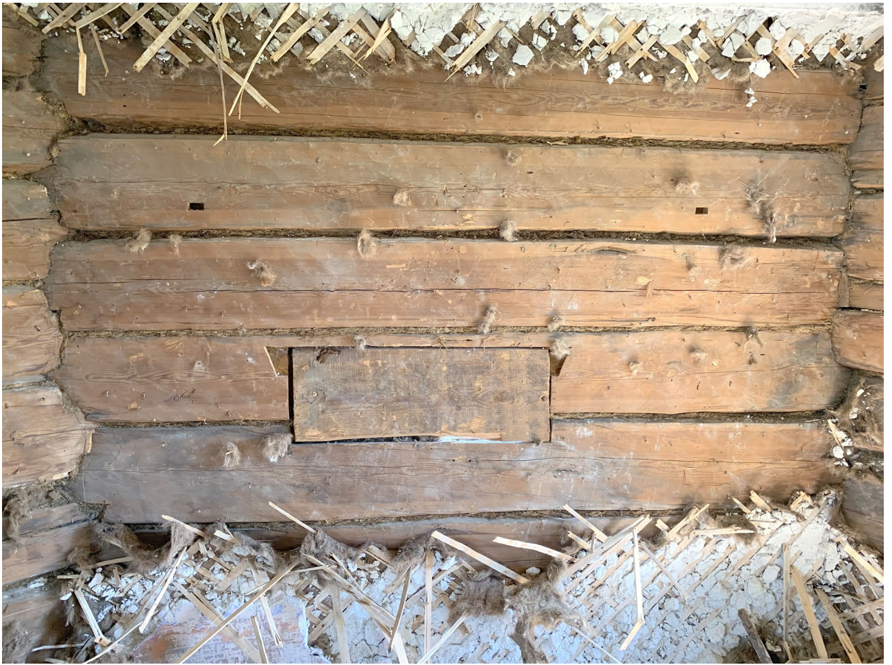
Илл. 115. Раскрытие волокового окна в интерьере.
