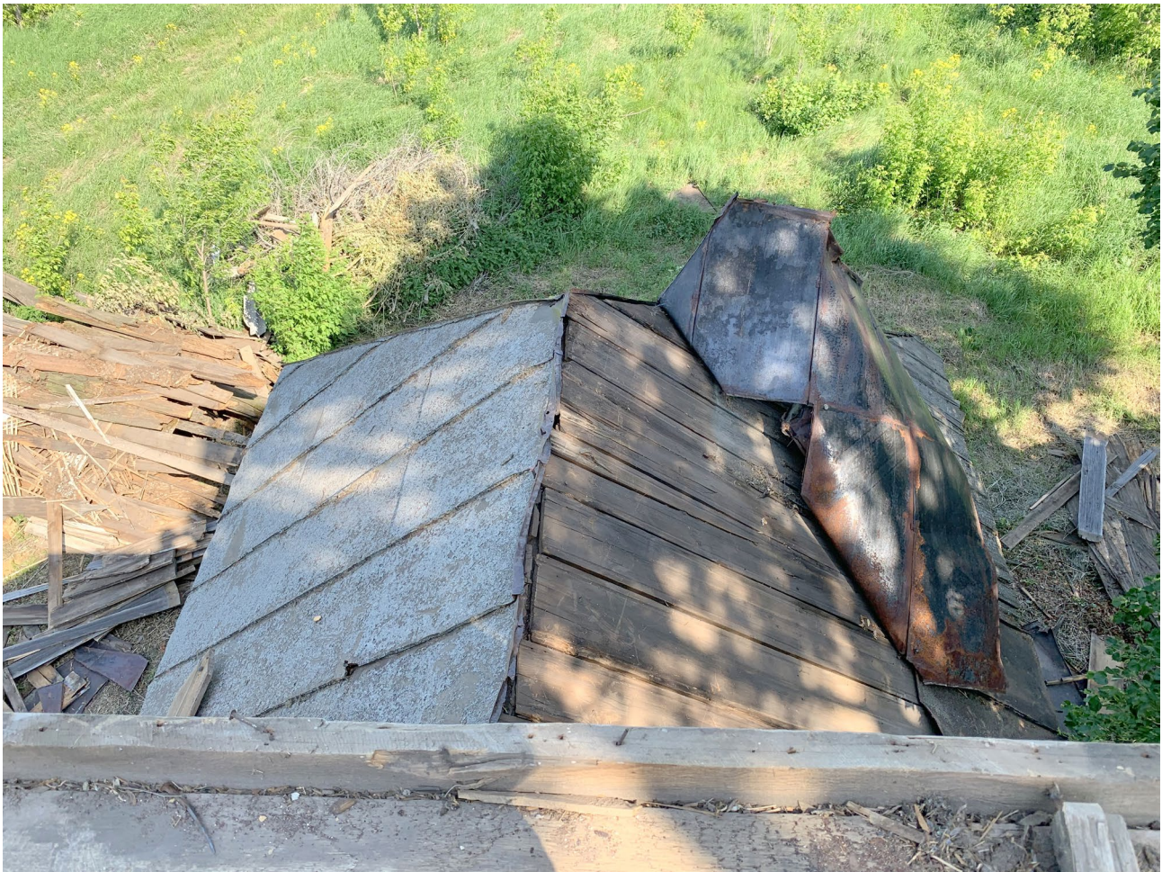
Илл. 41. Снятие покрытия кровли с объем алтаря.
