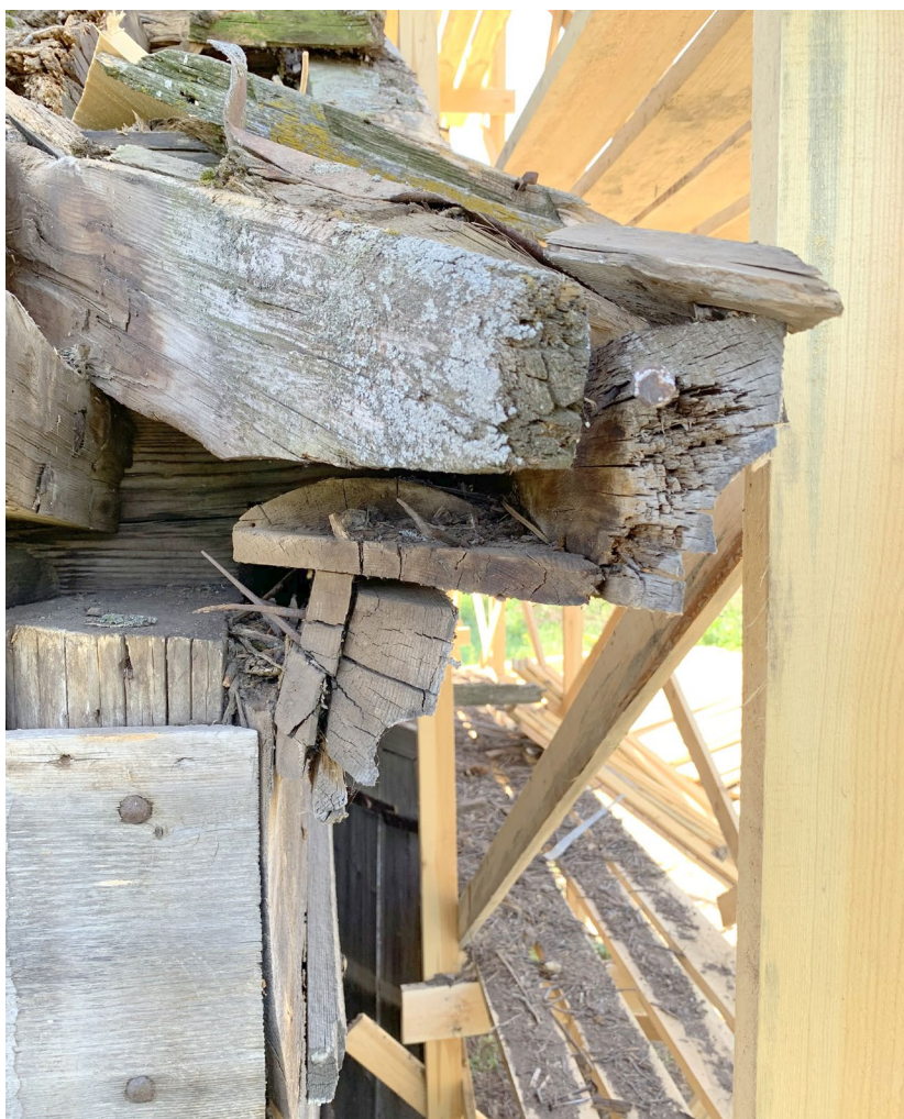
Илл. 56. Карнизный пояс притвора.
