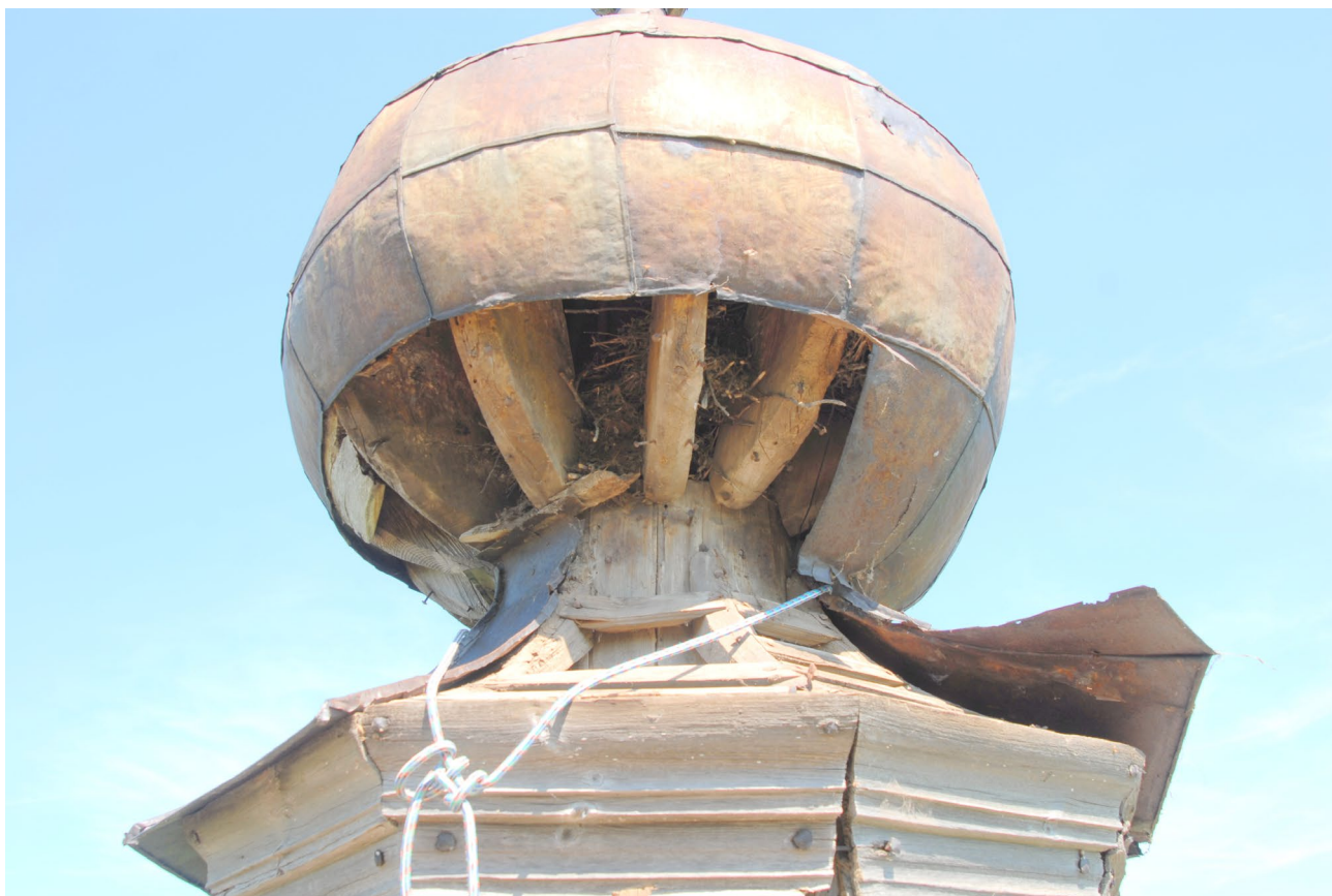
Илл. 16. Главка. Тип покрытия лежачий одинарный фальц чёрного железа. Фиксация журавцов главки к барабану XVIII в. Стропила и прогоны конструкции юбки XIX в.
