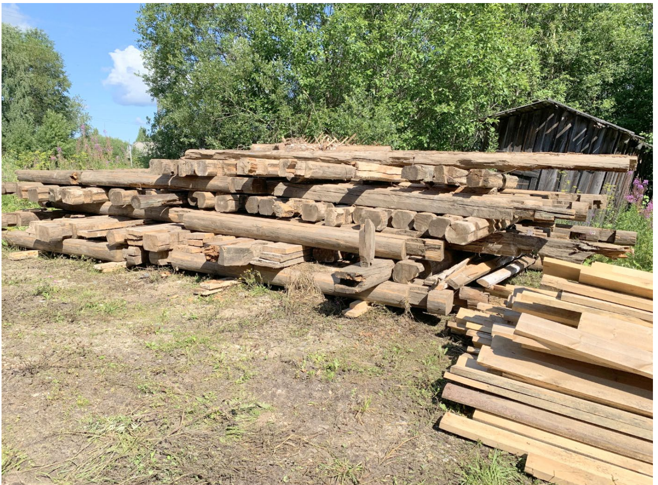
Илл. Д/16. Конструкции церкви на площадке в г. Кириллове. Складирование конструкций в штабеле для аэрации.
