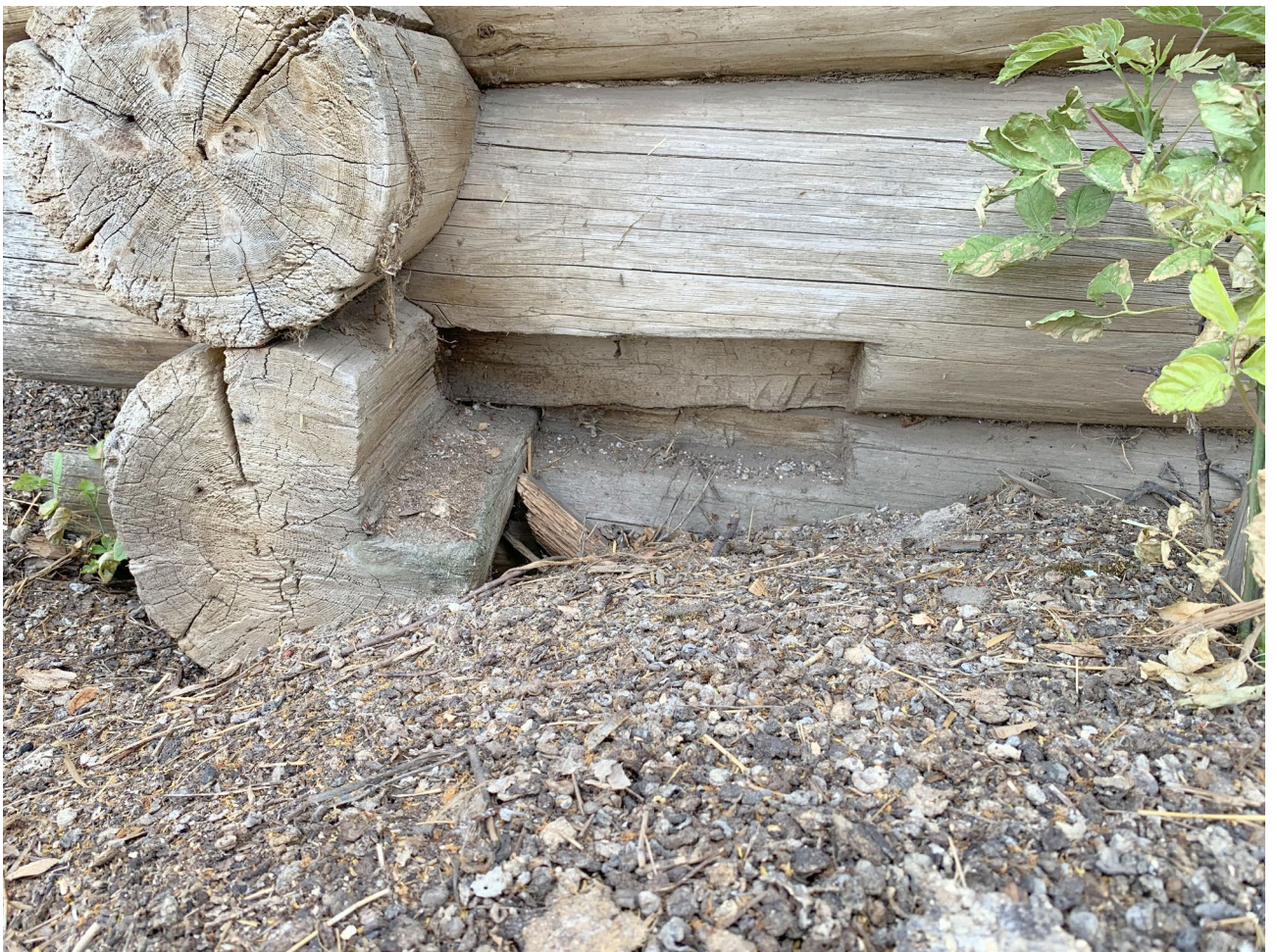
Илл. 89. Врубка скамьи на северном фасаде кафоликона.
