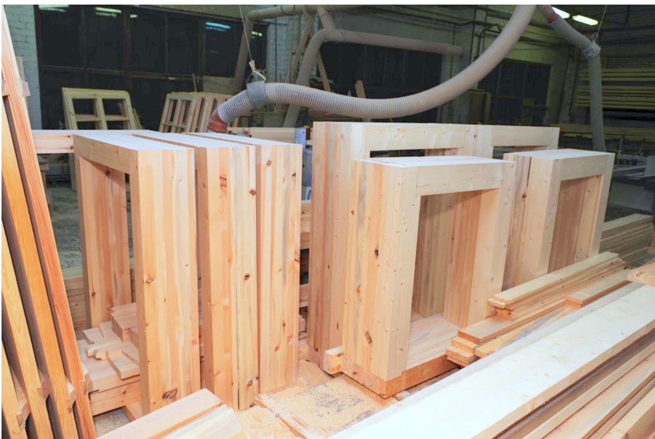
Илл. Д/9. Воссоздание оконных коробок.
