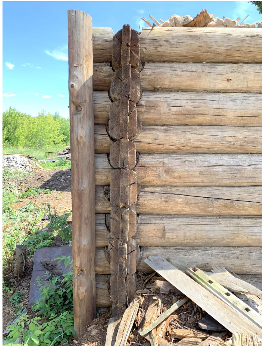
Илл. 94. Выпуски северной стены трапезной протёсанные на два канта и с гребнем, для прируба притвора.
