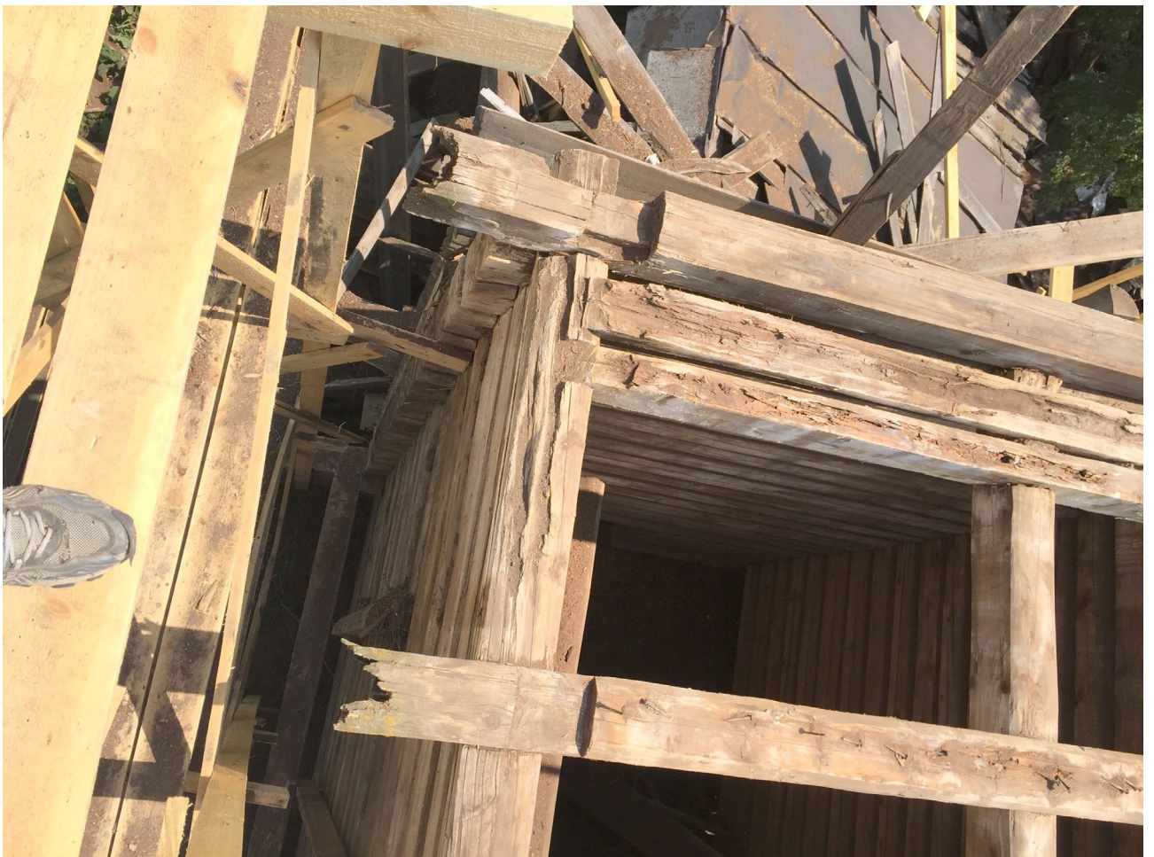
Илл. 80. Конструкция пола яруса звона колокольни. Балки пола яруса звона и желоб водосброса.
