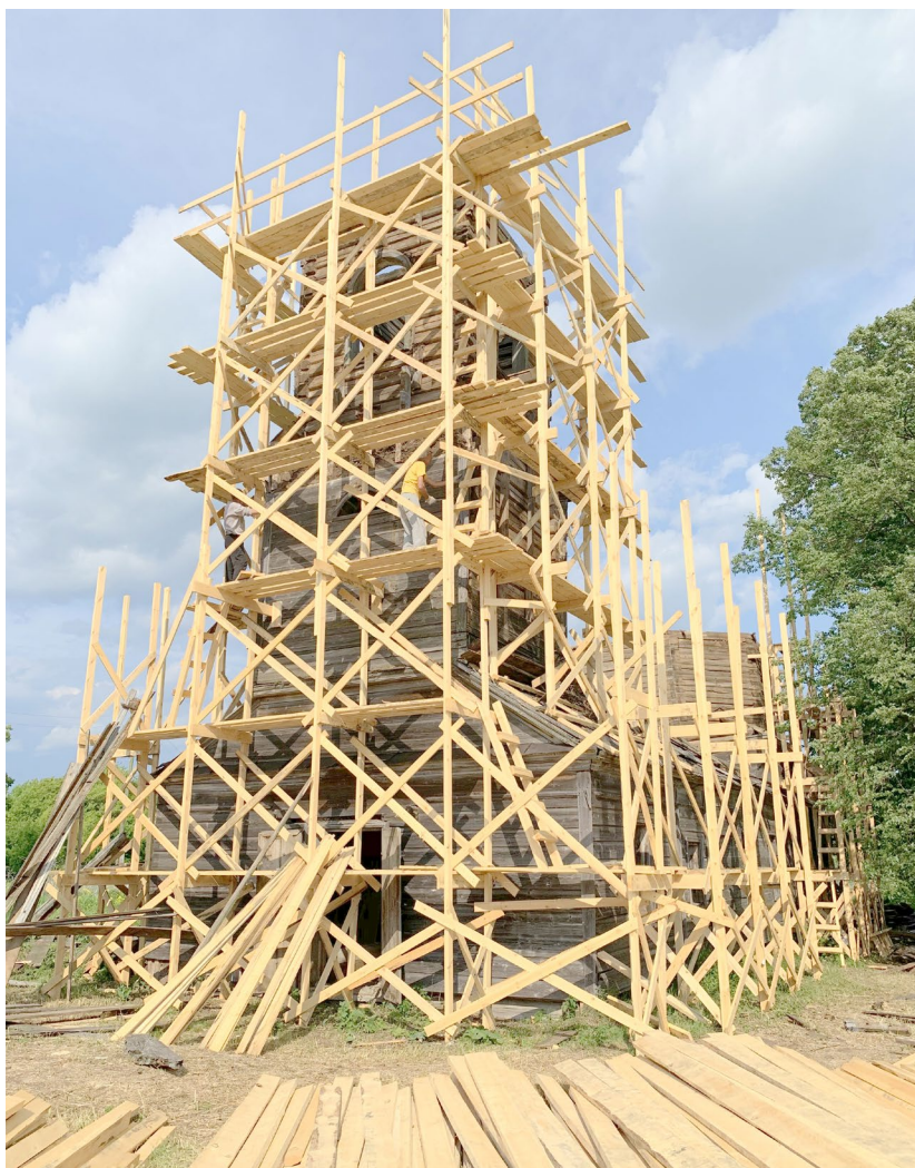
Илл. 55. Этап начала разборки колокольни. Вид с юго-запада.
