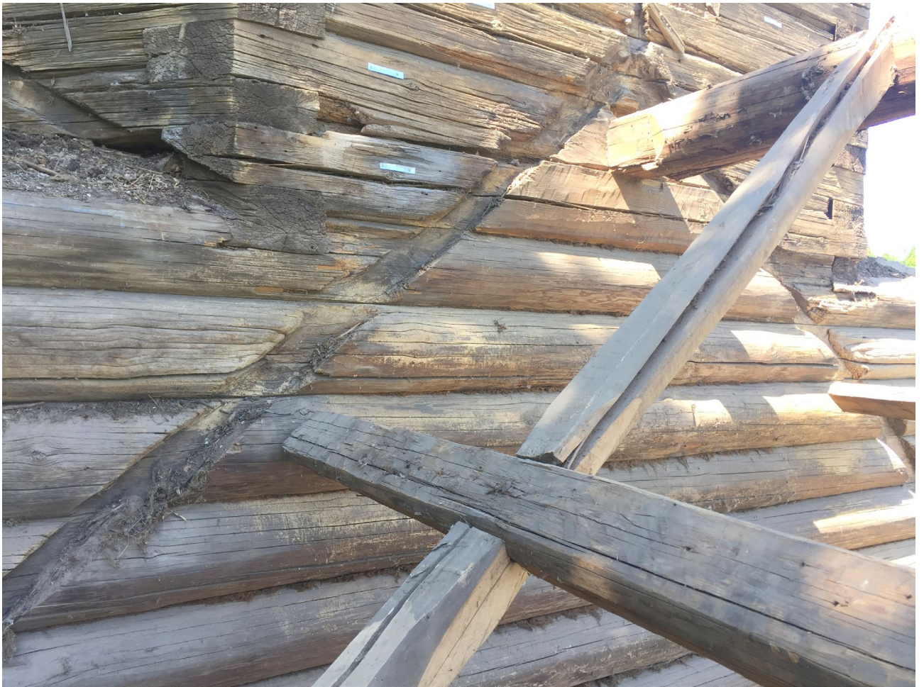
Илл. 85. Штроба под тѣс конструкции кровли алтаря в XVIII в.
