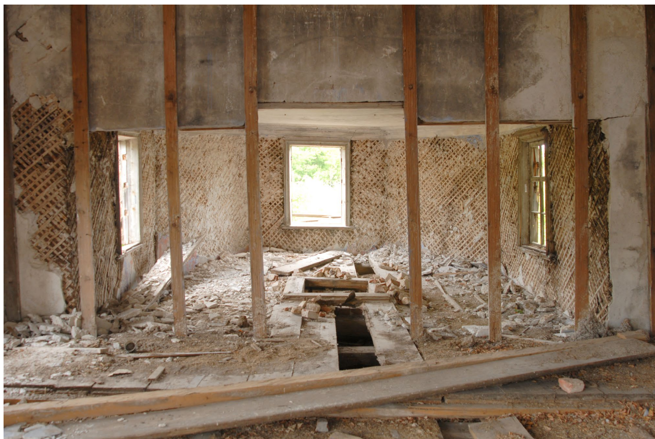
Илл. 98. Сбивка штукатурки в объёме алтаря.
