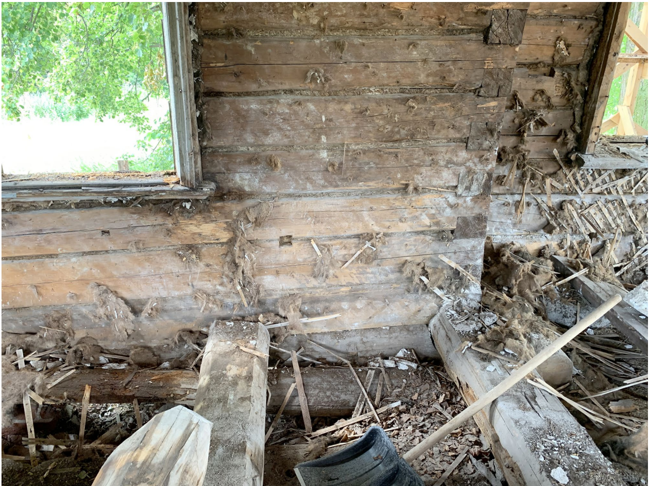
Илл. 131. Следы церковной утвари в объёме алтаря.
