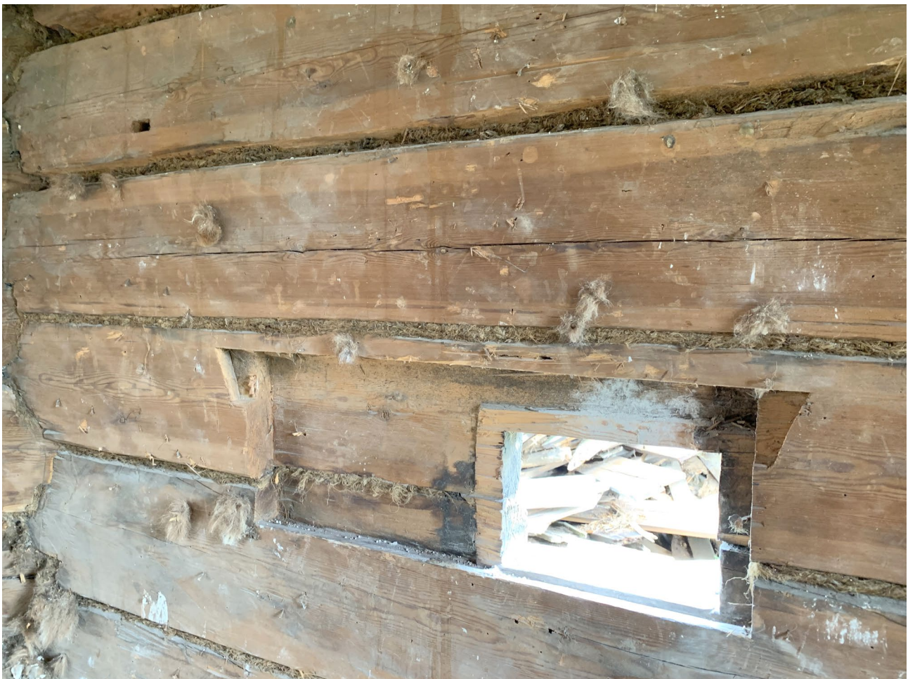
Илл. 128. Следы церковной утвари в объёме алтаря.
