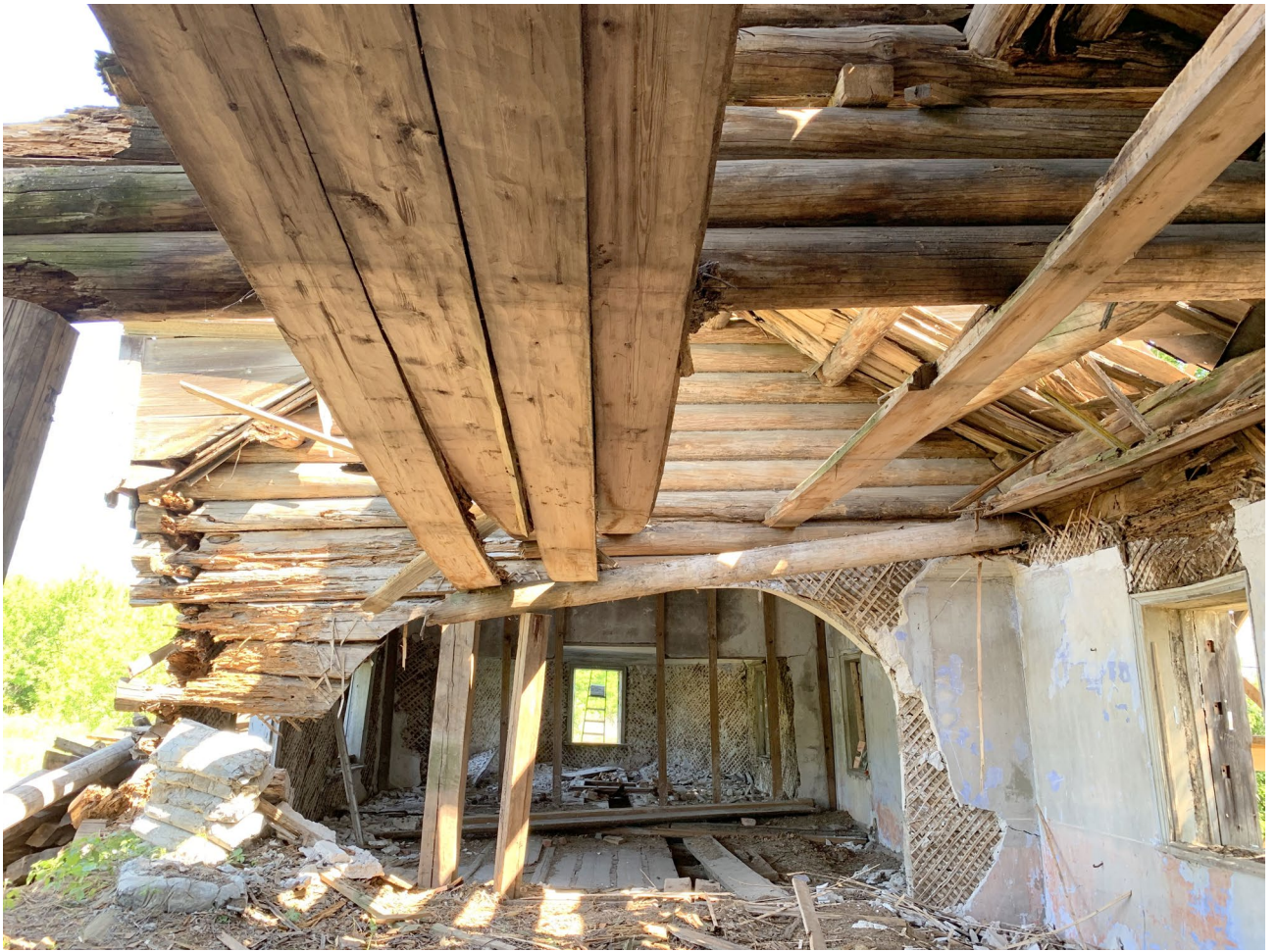
Илл. 1. Стойки удерживающие обрушение потолка трапезной и западной стены кафоликона.
