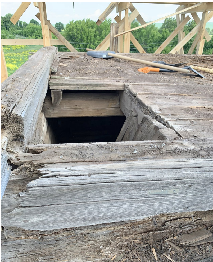
Илл. 74. Конструкция пола яруса звона колокольни. Желоб водосброса установленный под углом к срубу для защиты юго-восточного угла.
