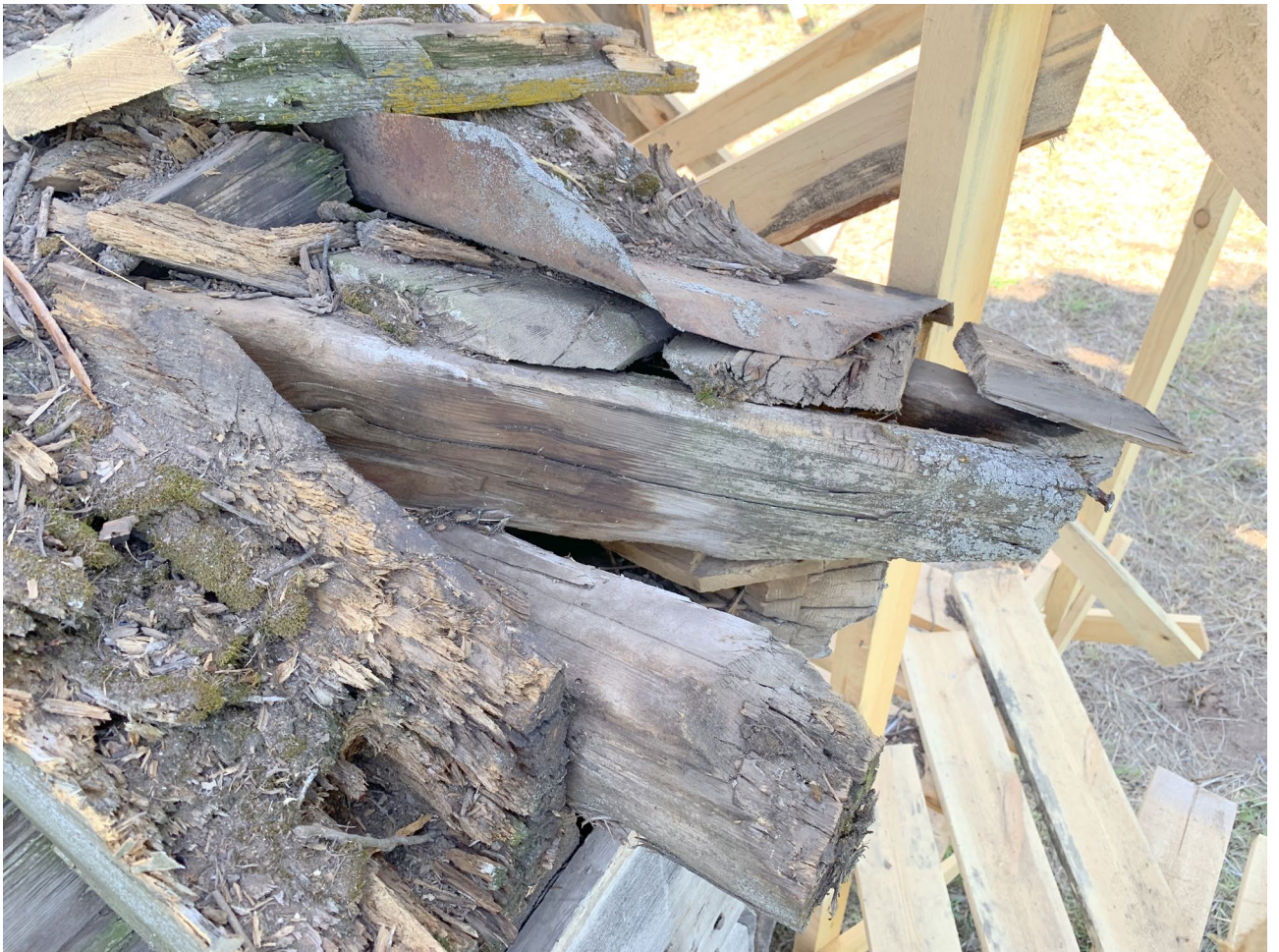
Илл. 57. Карнизный пояс притвора. Вид сверху.
