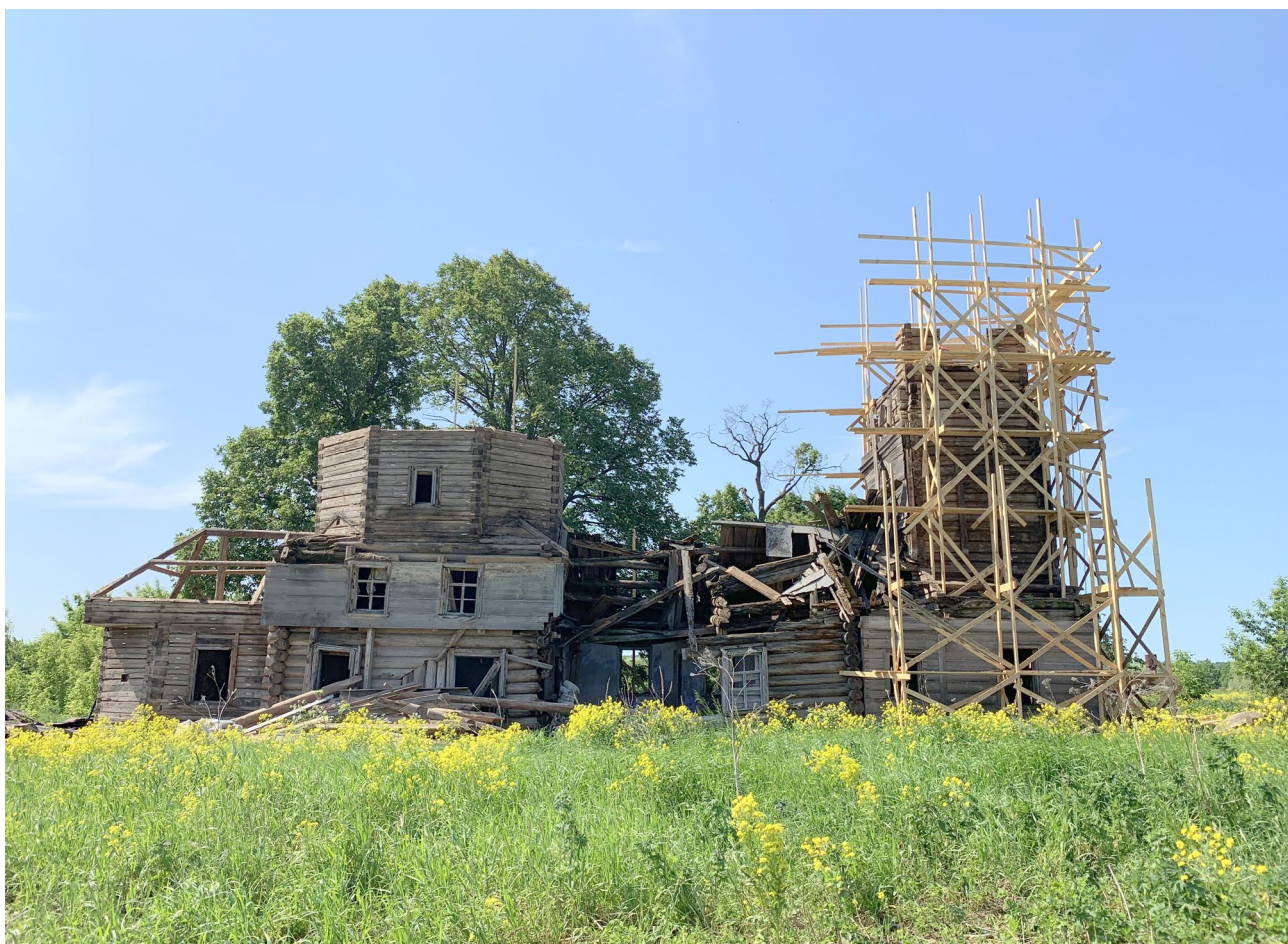
Илл. 68. Разборка сруба яруса звона. Вид с севера.
