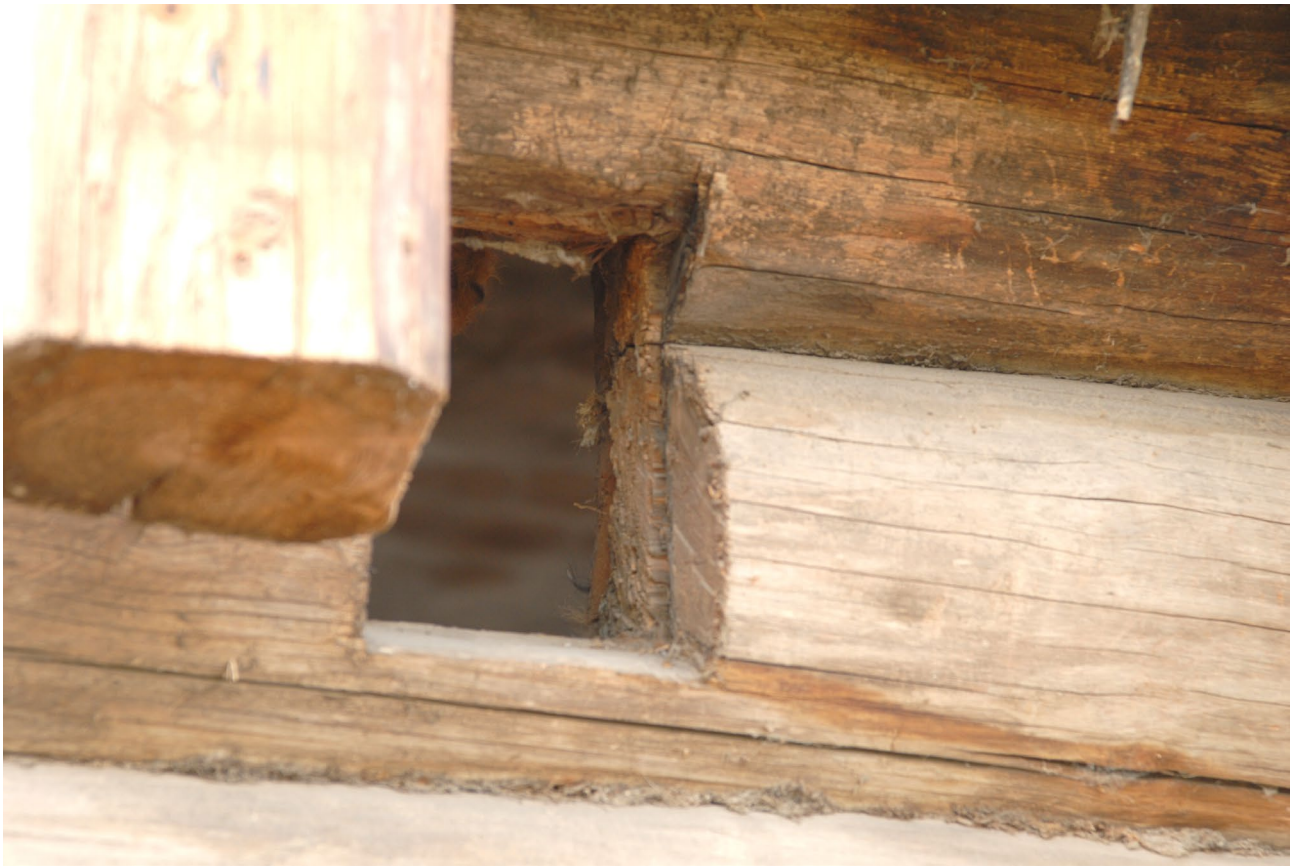
Илл. 151. Прорубленное насквозь гнездо кровли галереи-паперти XVIII в.
