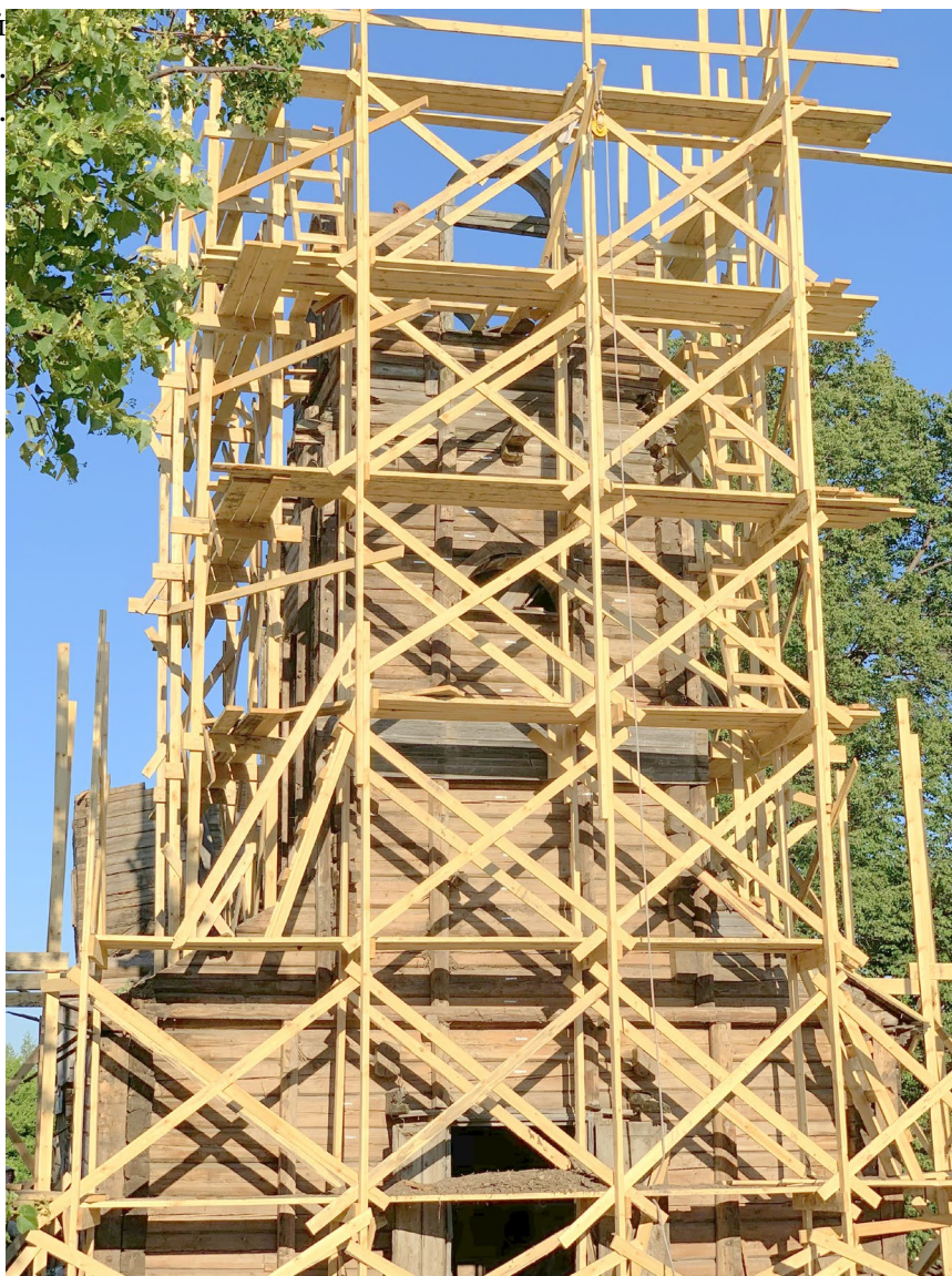
Илл. 67. Разборка конструкций колокольни. Вид с запада.
