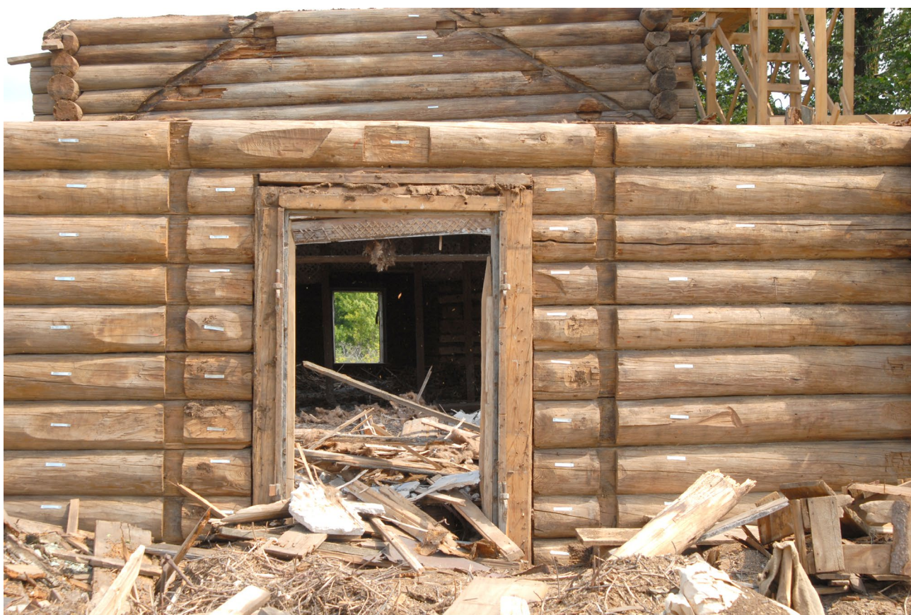
Илл. 150. Затёски дверного проёма XVIII в. Общий вид.
