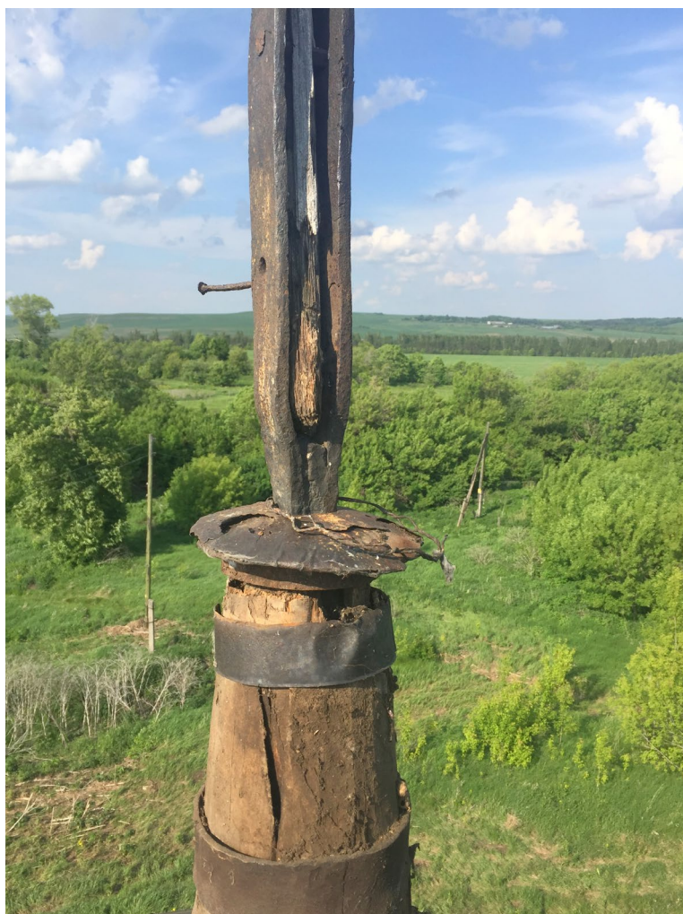
Илл. 12. Кольца и хомут соединения основания креста с подкрестным столбом.
