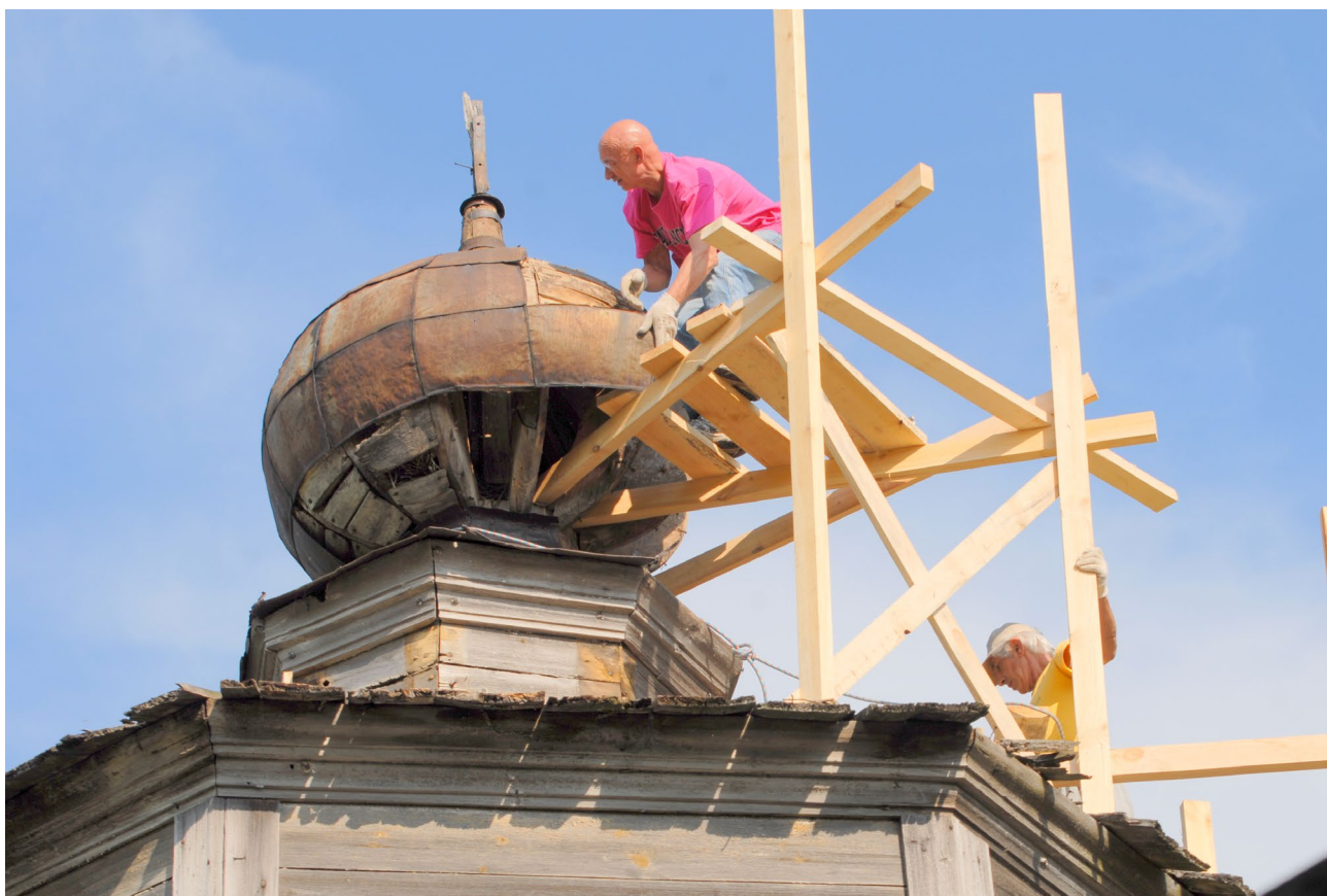
Илл. 6. Снятие покрытия главки.
