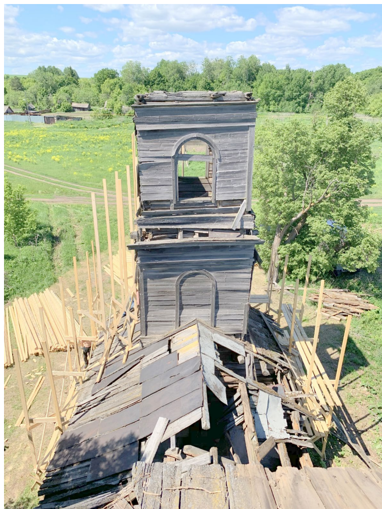
Илл. 14. Возведение лесов вокруг колокольни. Вид с востока.
