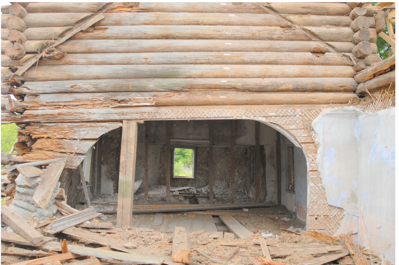
Илл. 108. Растѣсанный в XIX в. проѣм между кафоликоном и трапезной.
