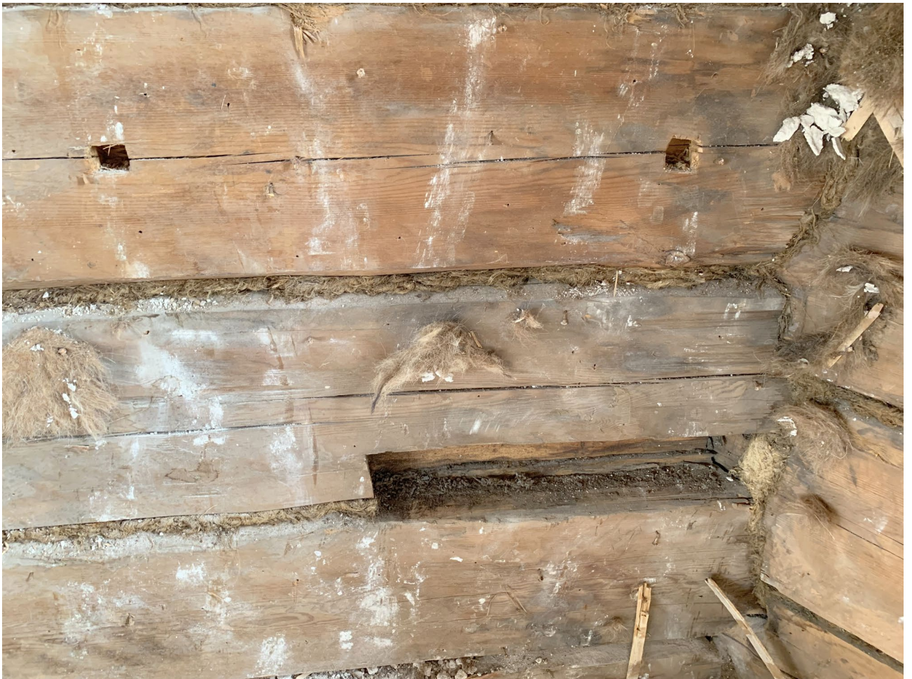
Илл. 127. Следы церковной утвари в объёме алтаря.
