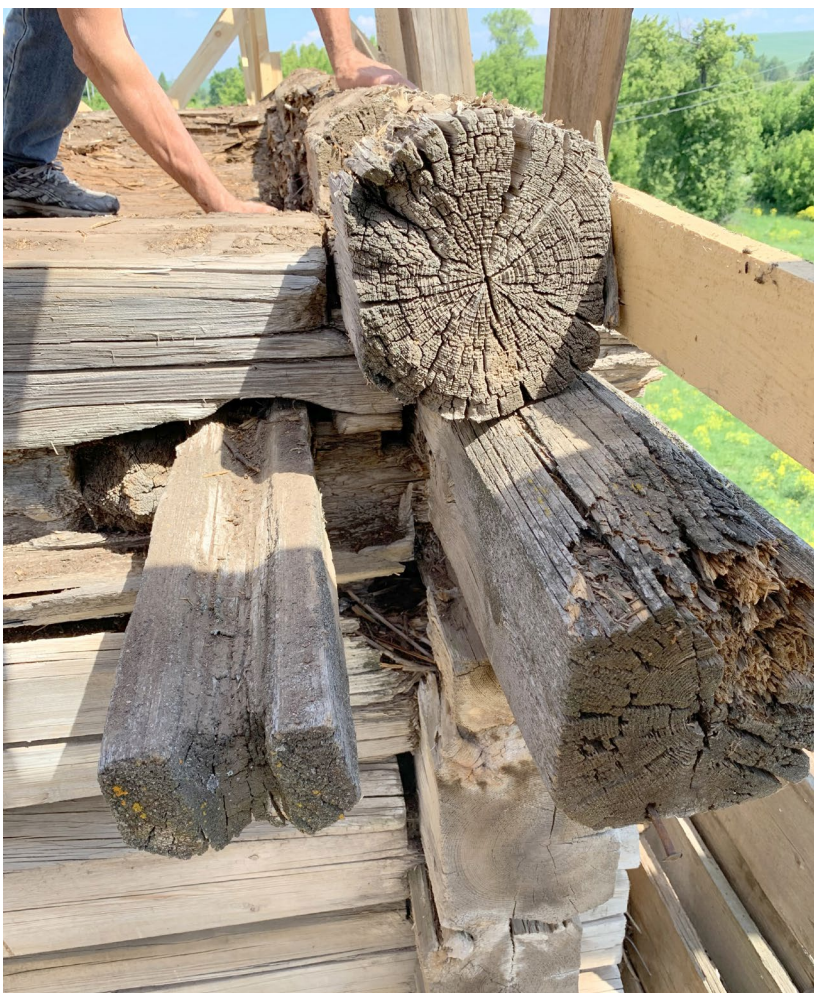
Илл. 75. Конструкция пола яруса звона колокольни. Желоб водосброса. Вид с юга.
