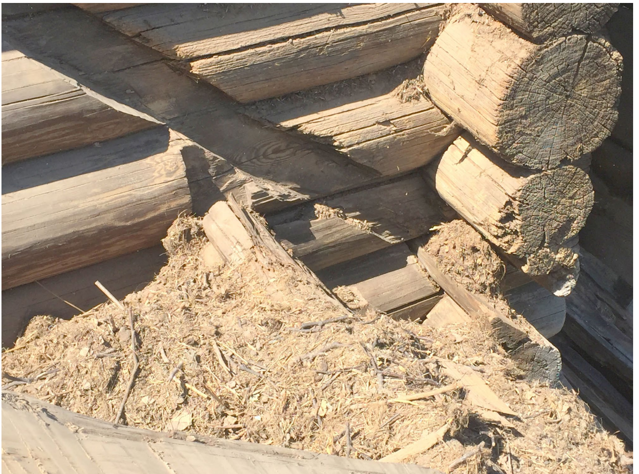
Илл. 138. Штроба под северную стену алтаря в восточной стене кафоликона. Верхние брёвна сруба алтаря не перевязывались со срубом кафоликона.
