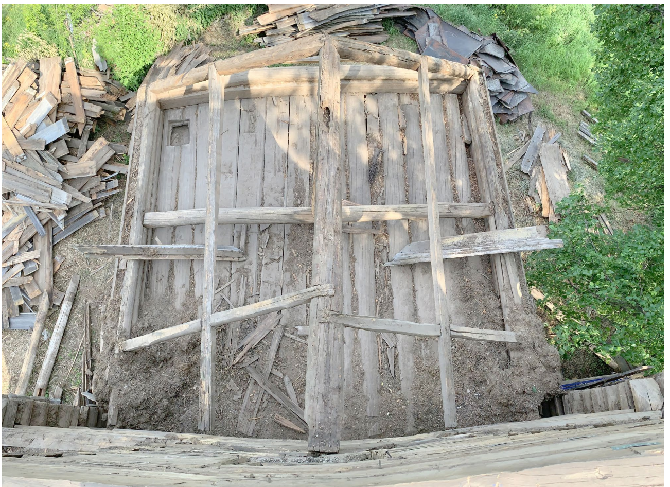
Илл. 144. Потолок алтаря из плах. Продух в северо-восточном углу перекрытия.
