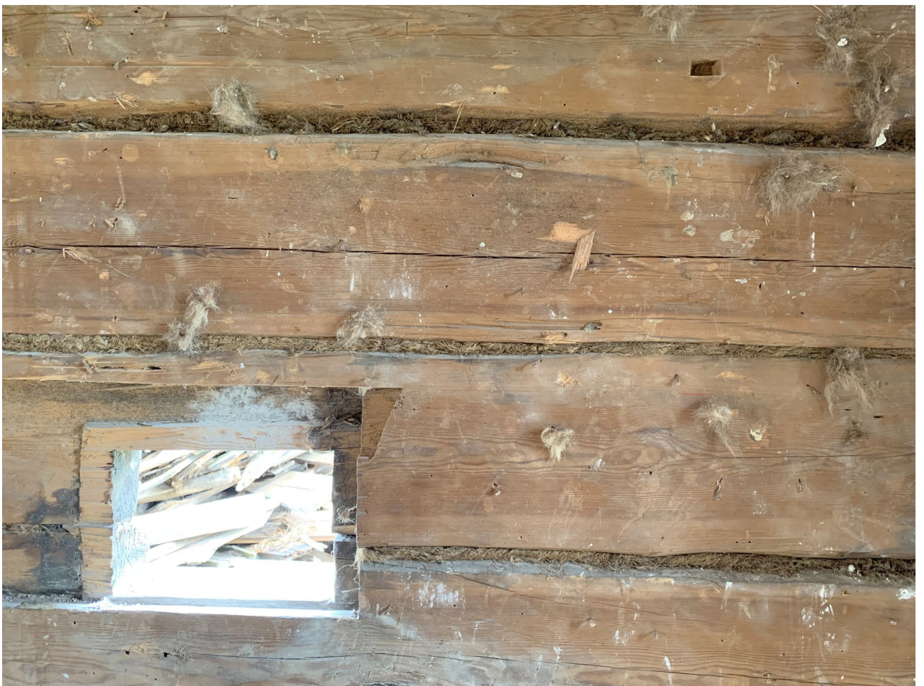
Илл. 132. Следы церковной утвари в объёме алтаря.
