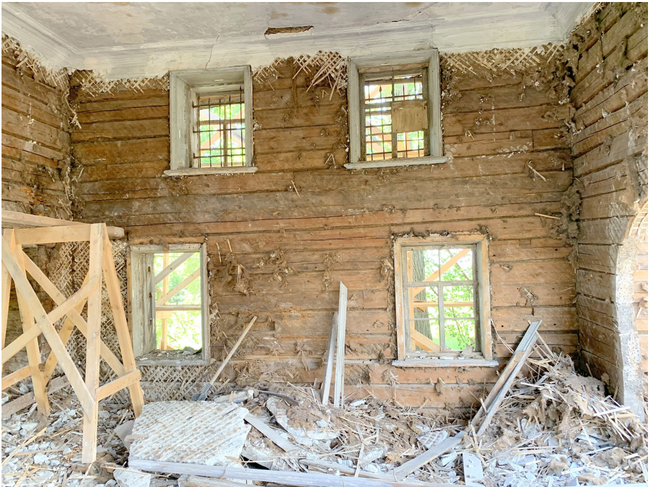
Илл. 101. Сбивка штукатурки в объём кафоликона.
