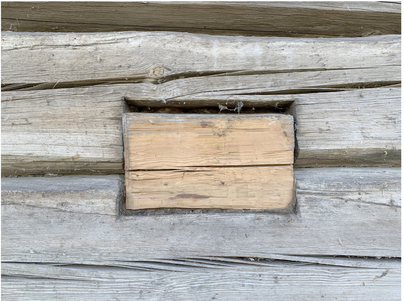
Илл. 49. Снятие обшивки с алтаря. Раскрытие волокового окна.
