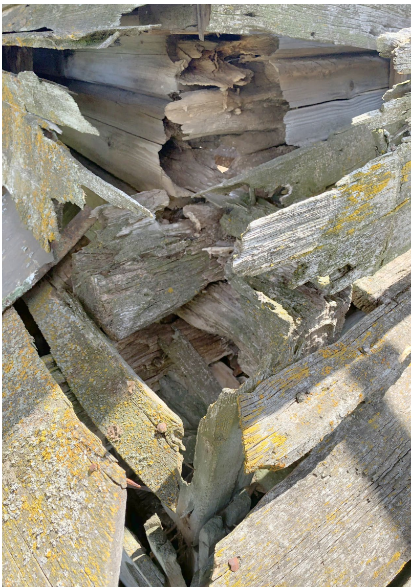
Илл. 65. Состояние углов сруба колокольни. Уширение сруба под ярусом звона.
