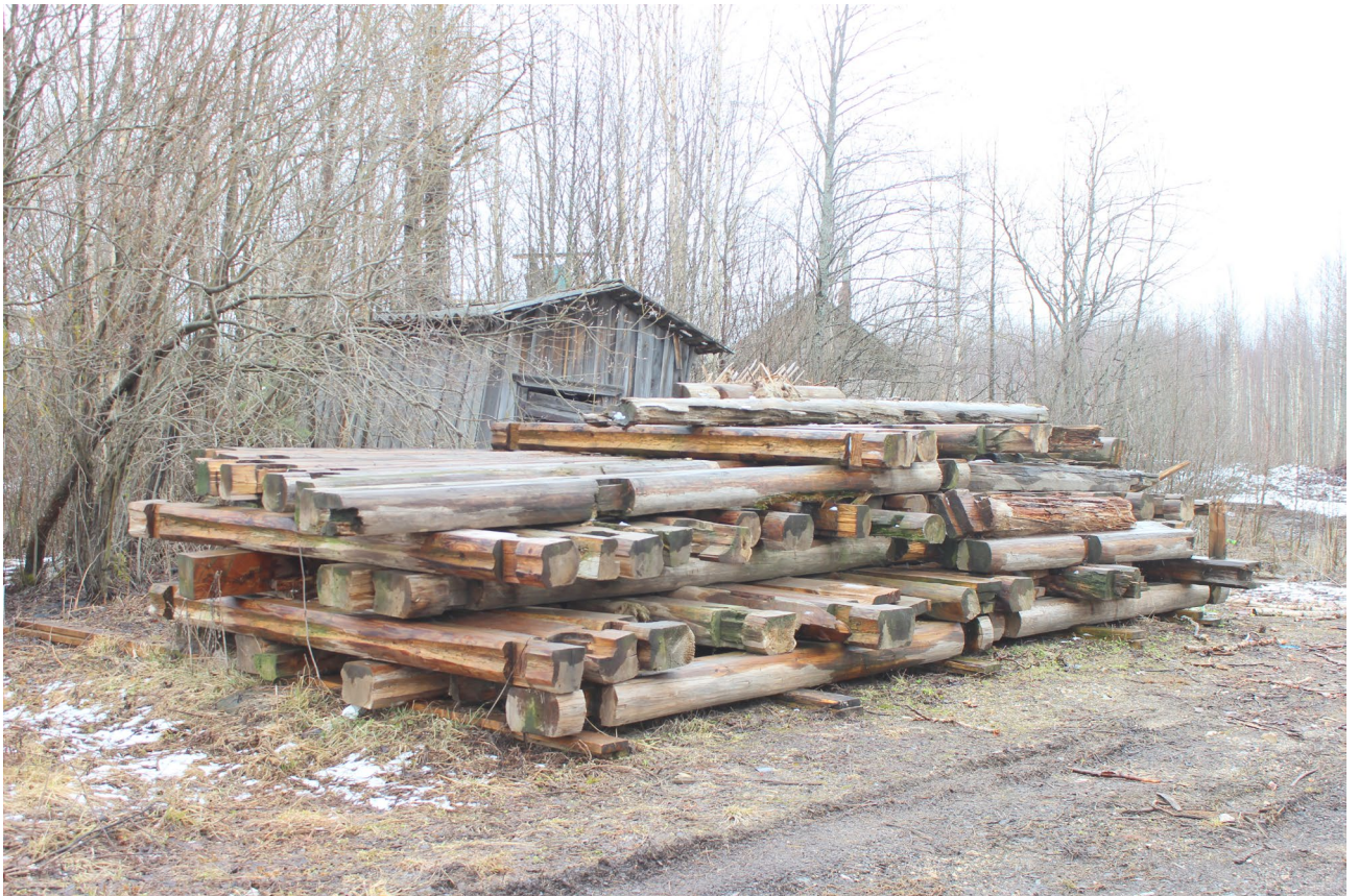
Илл. Д/14. Конструкции церкви на площадке в г. Кириллове. Складирование конструкций в штабеле для аэрации.
