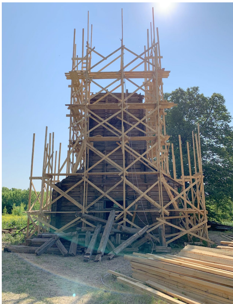
Илл. 70. Этап разборки пола яруса звона. Вид с запада.
