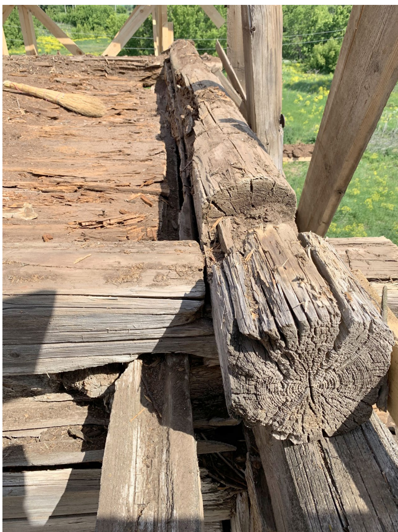
Илл. 76. Конструкция пола яруса звона колокольни. Подход теса к желобу. Вид с юга .
