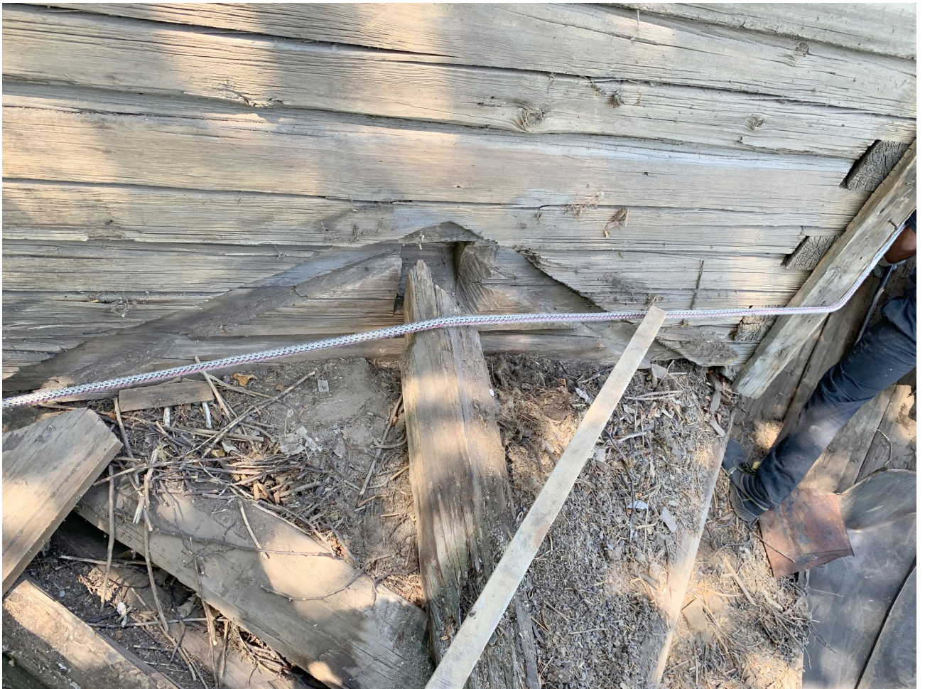
Илл. 39. Штроба под тес и гнездо под стропило. Юго-восточный зауголок.
