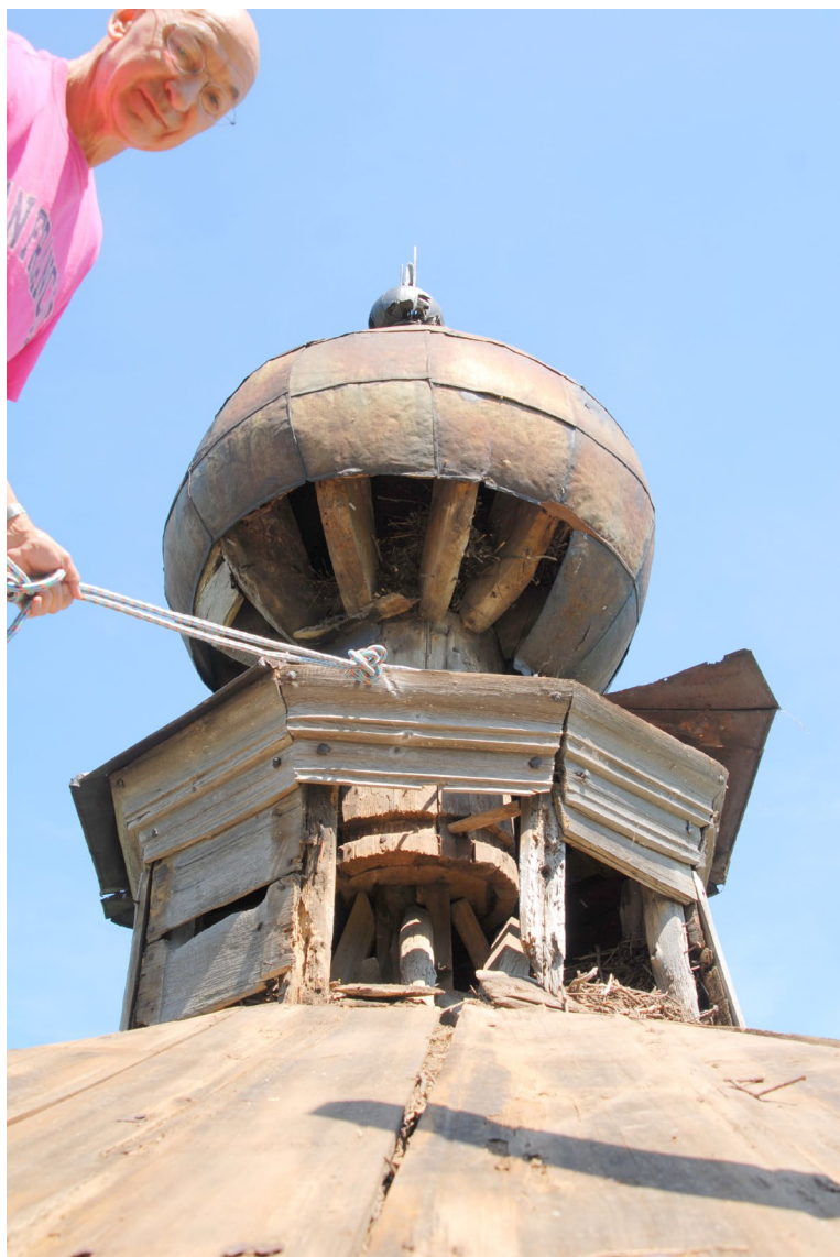
Илл. 19. Подлинные конструкции XVIII в. под третьим восьмериком.
