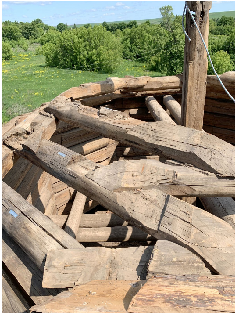
Илл. 31. Конструкция фиксации подкрестного столба внутри второго восьмерика.
