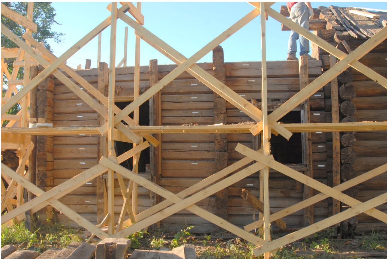
Илл. 82. Маркировка южного фасада притвора.
