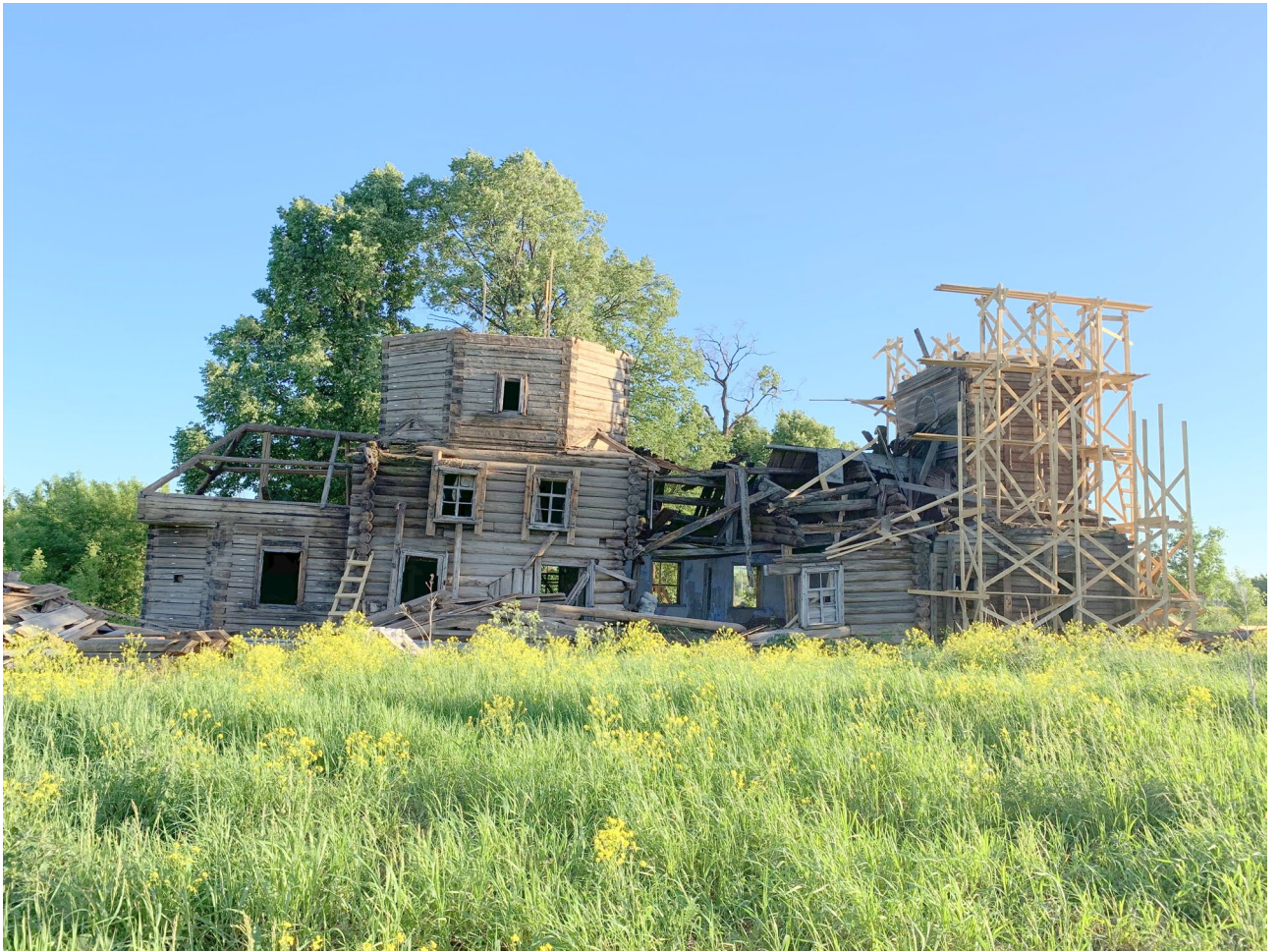
Илл. 83. Разборка конструкций колокольни на стадии балок пола яруса звона. Северный фасад.
