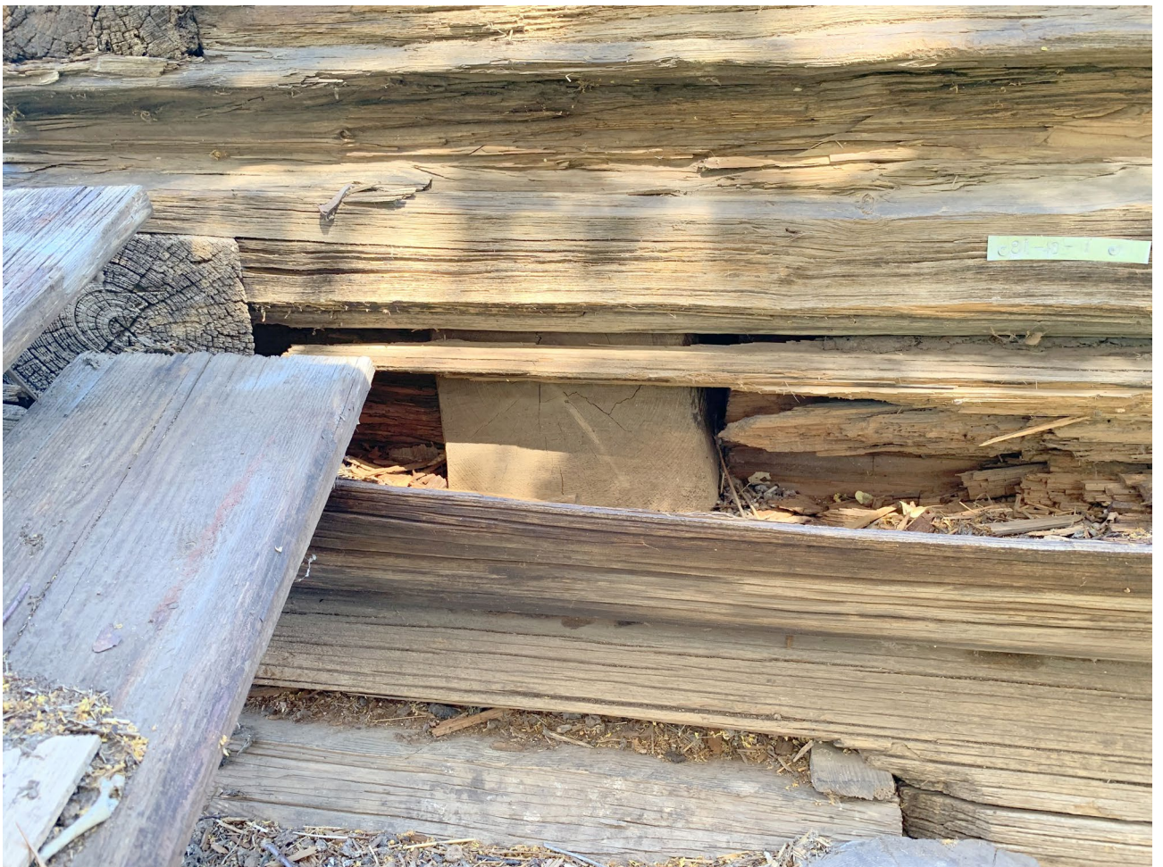
Илл. 143. Торец западной балки потолка кафоликона.
