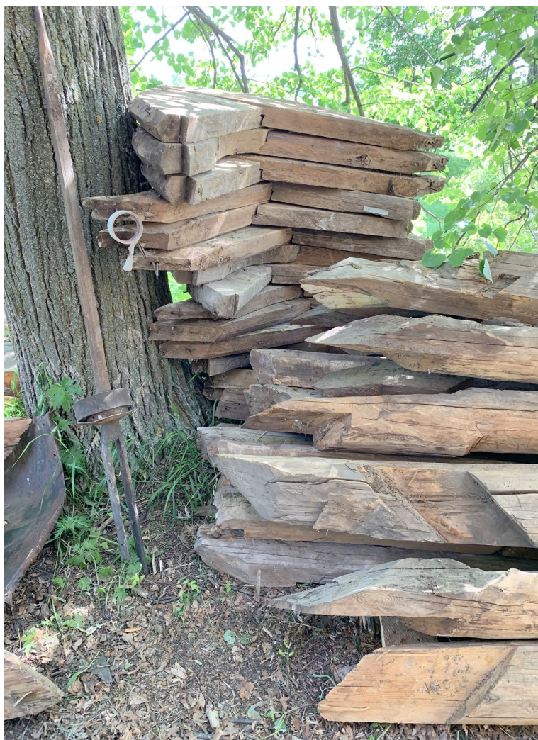
Илл. 13. Металлическое основание креста. Журавцы главы и режь второго восьмерика в штабеле.
