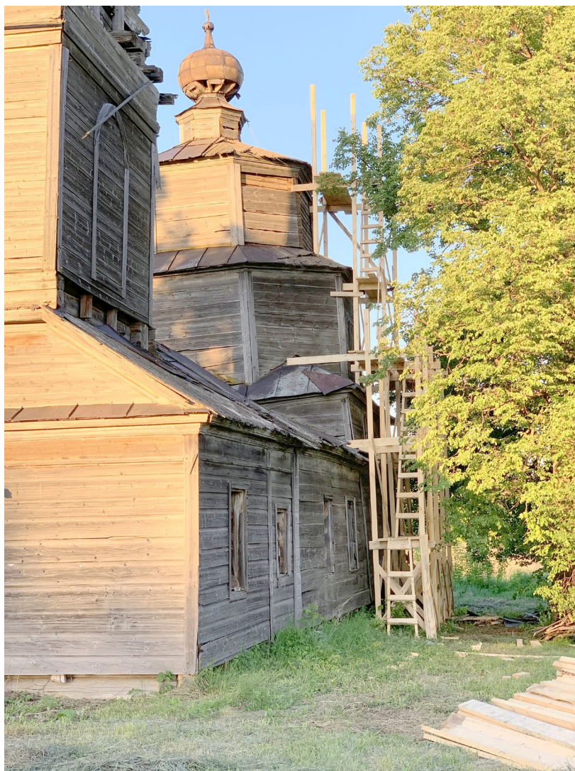
Илл. 4. Вид с северо-запада на стадии снятия покрытия кровли второго восьмерика.
