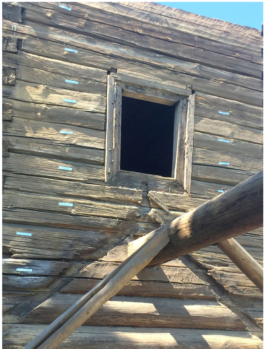
Илл. 96. Раскрытие слюдяного окна на восточной стене первого восьмерика.
