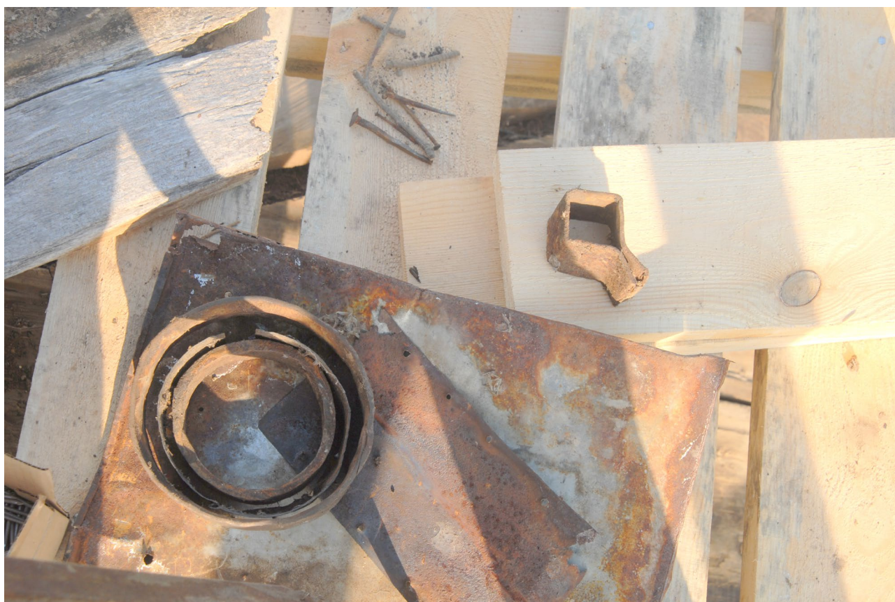
Илл. 12. Кольца и хомут соединения основания креста с подкрестным столбом.
