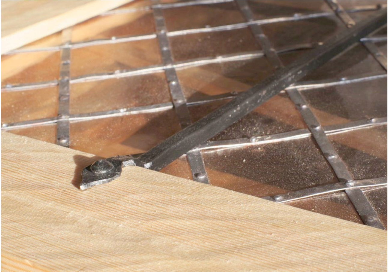
Илл. Д/1. Воссоздание слюдяных оконниц. Фрагмент с креплением стрелки.
