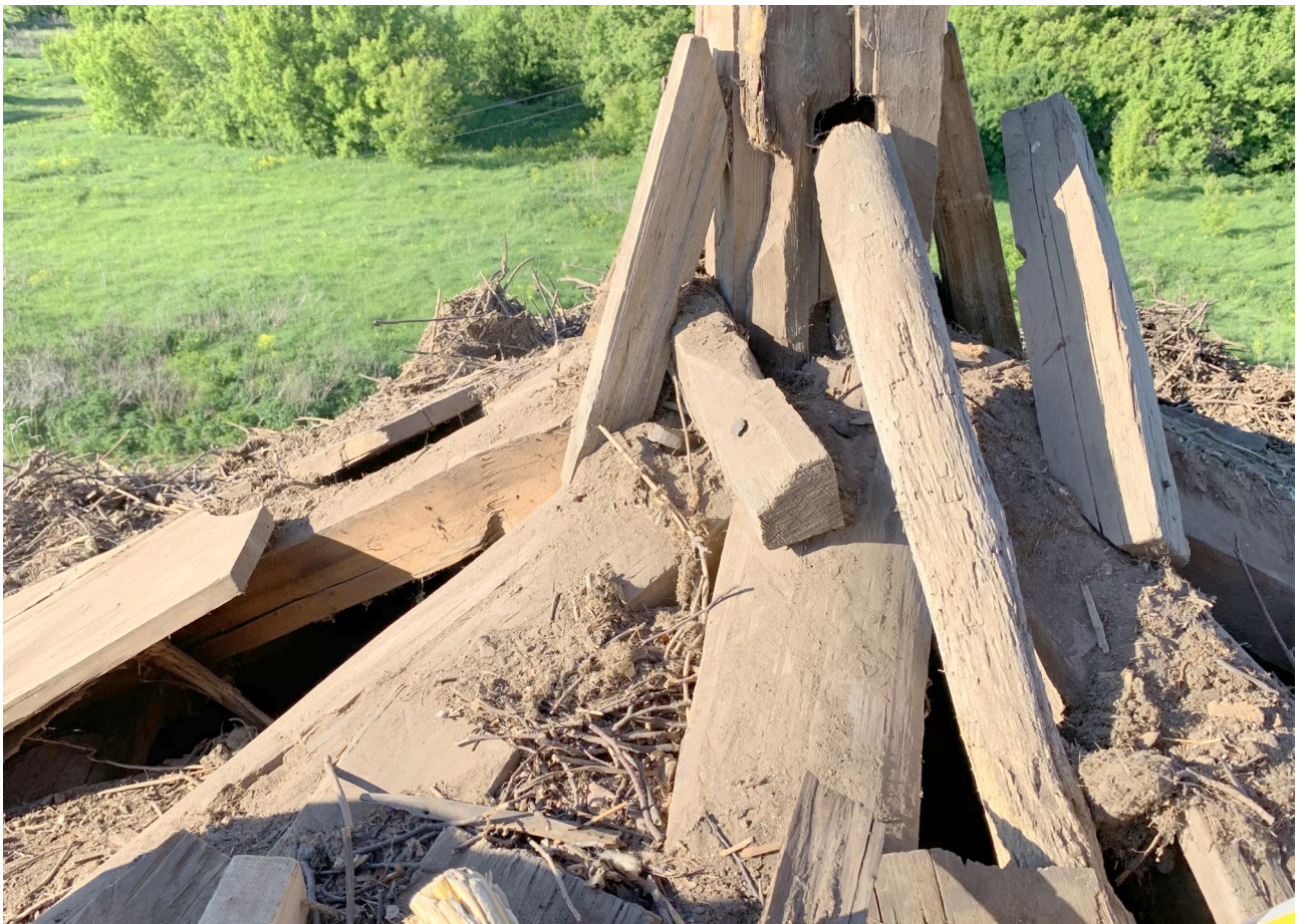
Илл. 26. Условная (возможно временная, не демонтированная) конструкция укрепления подкрестного столба.
