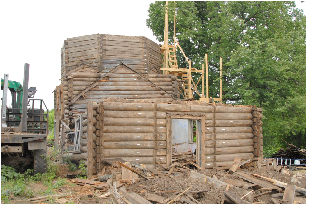
Илл. 106. Разборка сруба трапезной.
