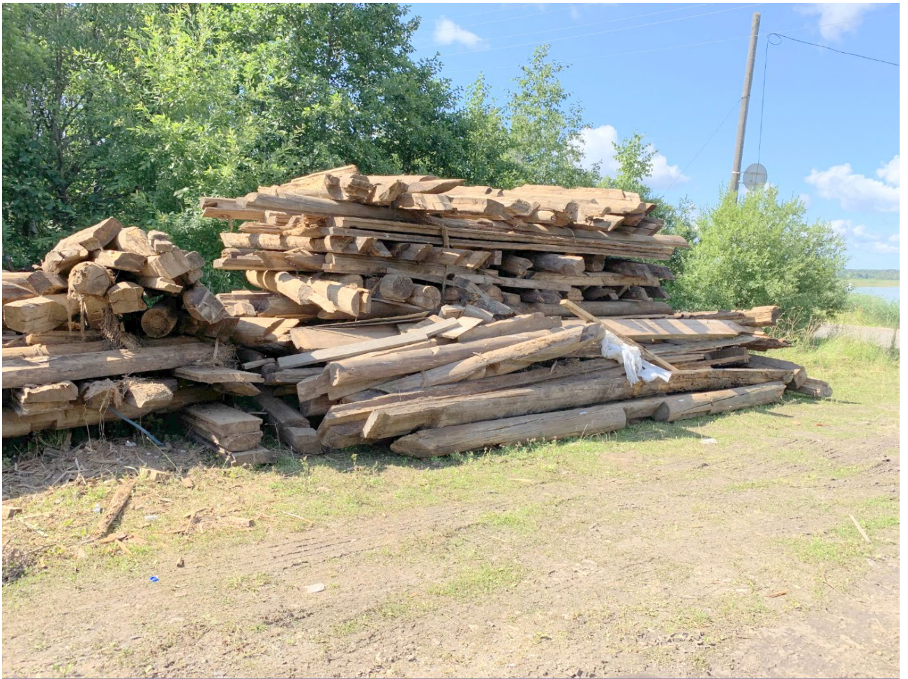
Илл. Д/17. Конструкции церкви на площадке в г. Кириллове. Складирование конструкций в штабеле для аэрации.
