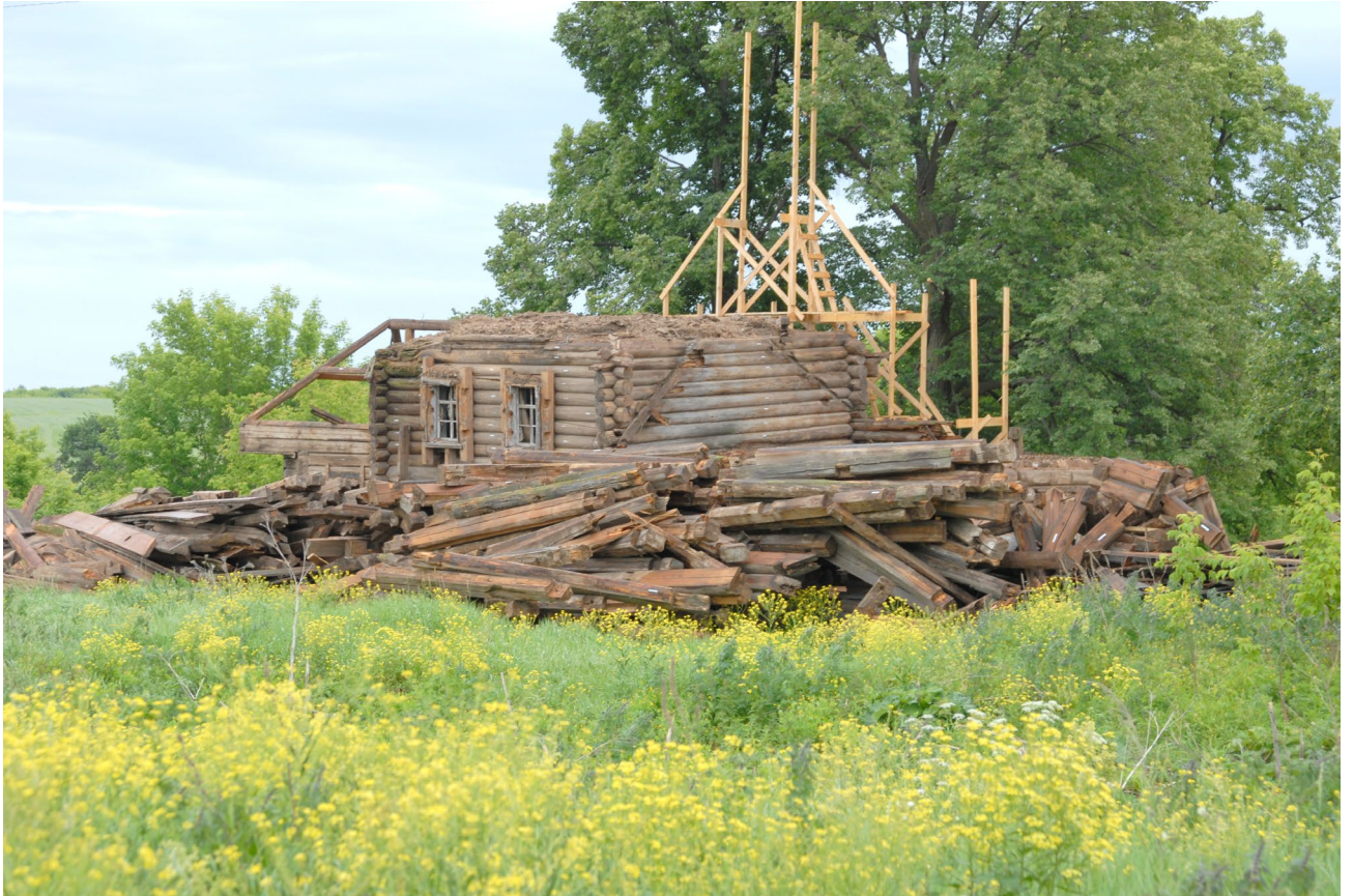
Илл. 105. Разборка сруба трапезной. Вид с северо-запада.
