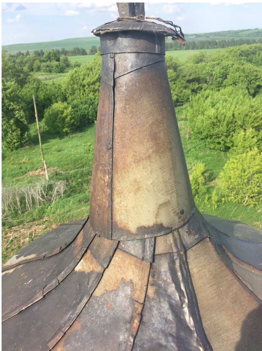
Илл. 5. Характер выполнения кровельного покрытия при переходе от креста к главке.
