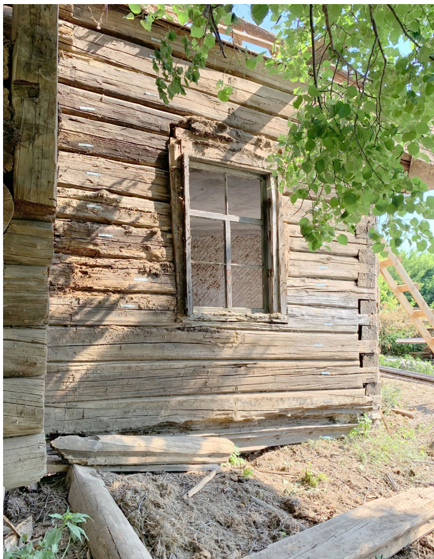
Илл. 51. Южная стена алтаря. Состояние сруба.
