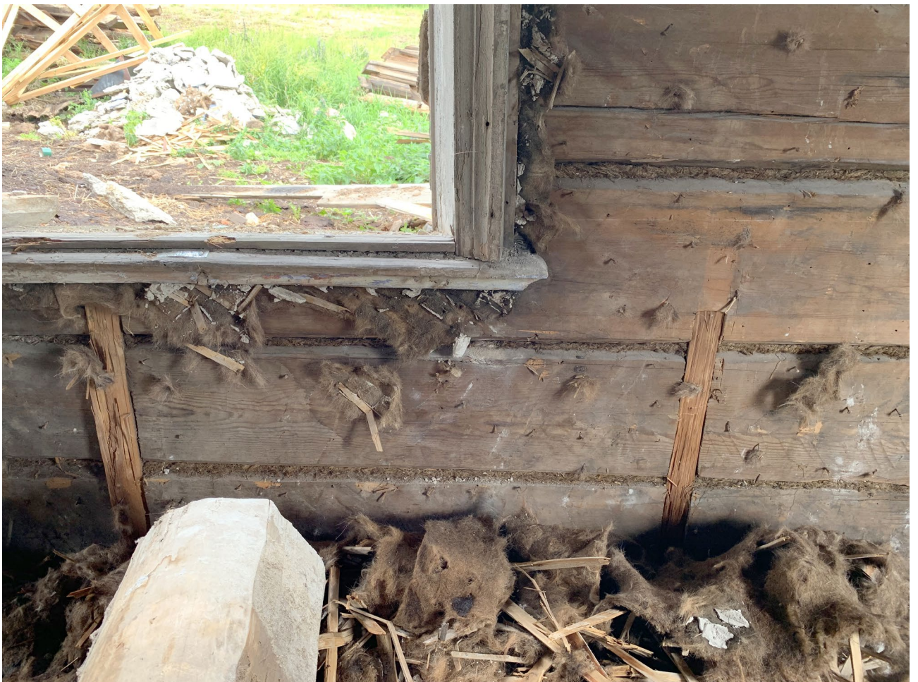
Илл. 130. Следы церковной утвари в объёме алтаря.
