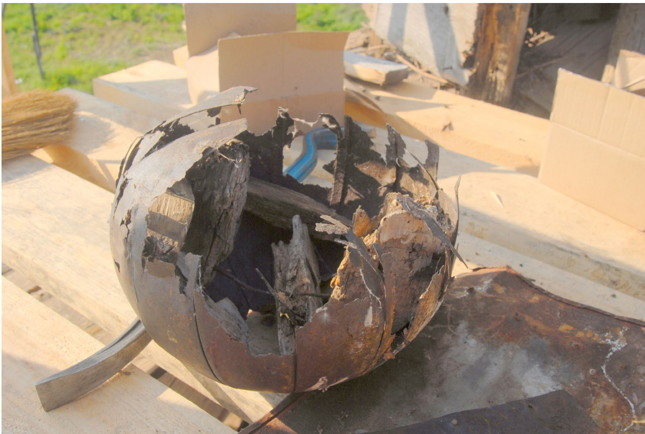
Илл. 7. Конструкция и состояние подкестного яблока.
