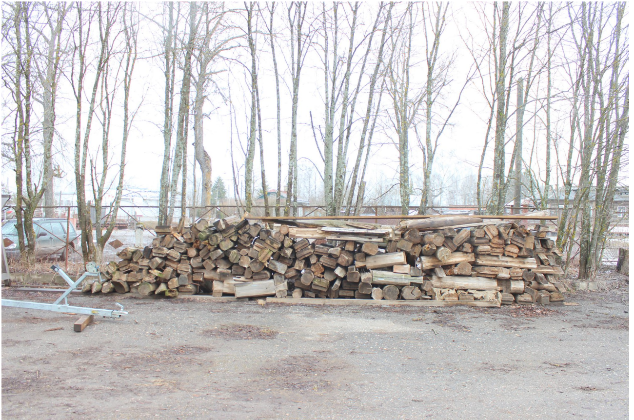
Илл. Д/15. Конструкции церкви на площадке в г. Кириллове. Складирование конструкций в штабеле для аэрации.
