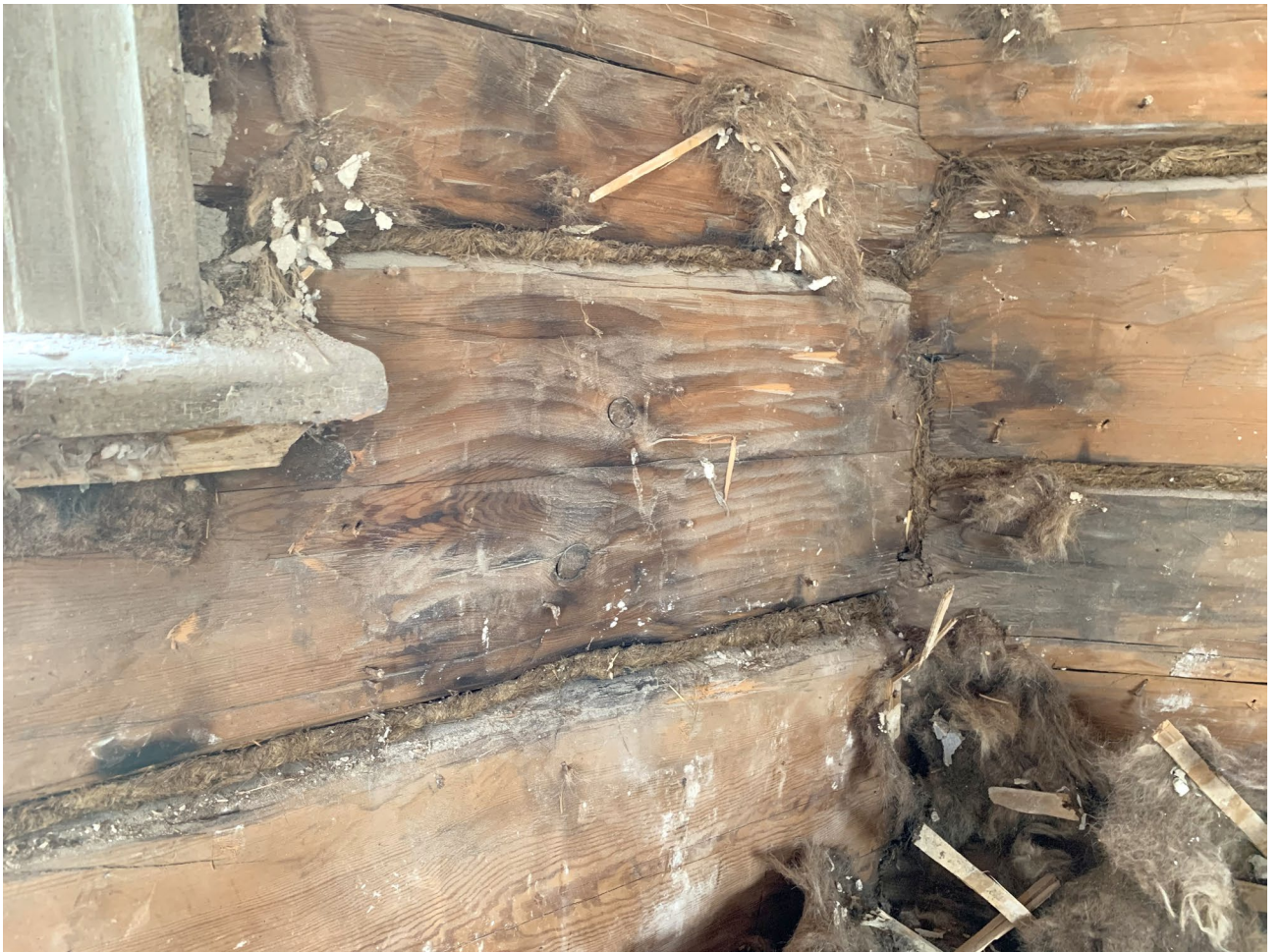
Илл. 123. Характер обработки брёвен сруба в интерьере алтаря.
