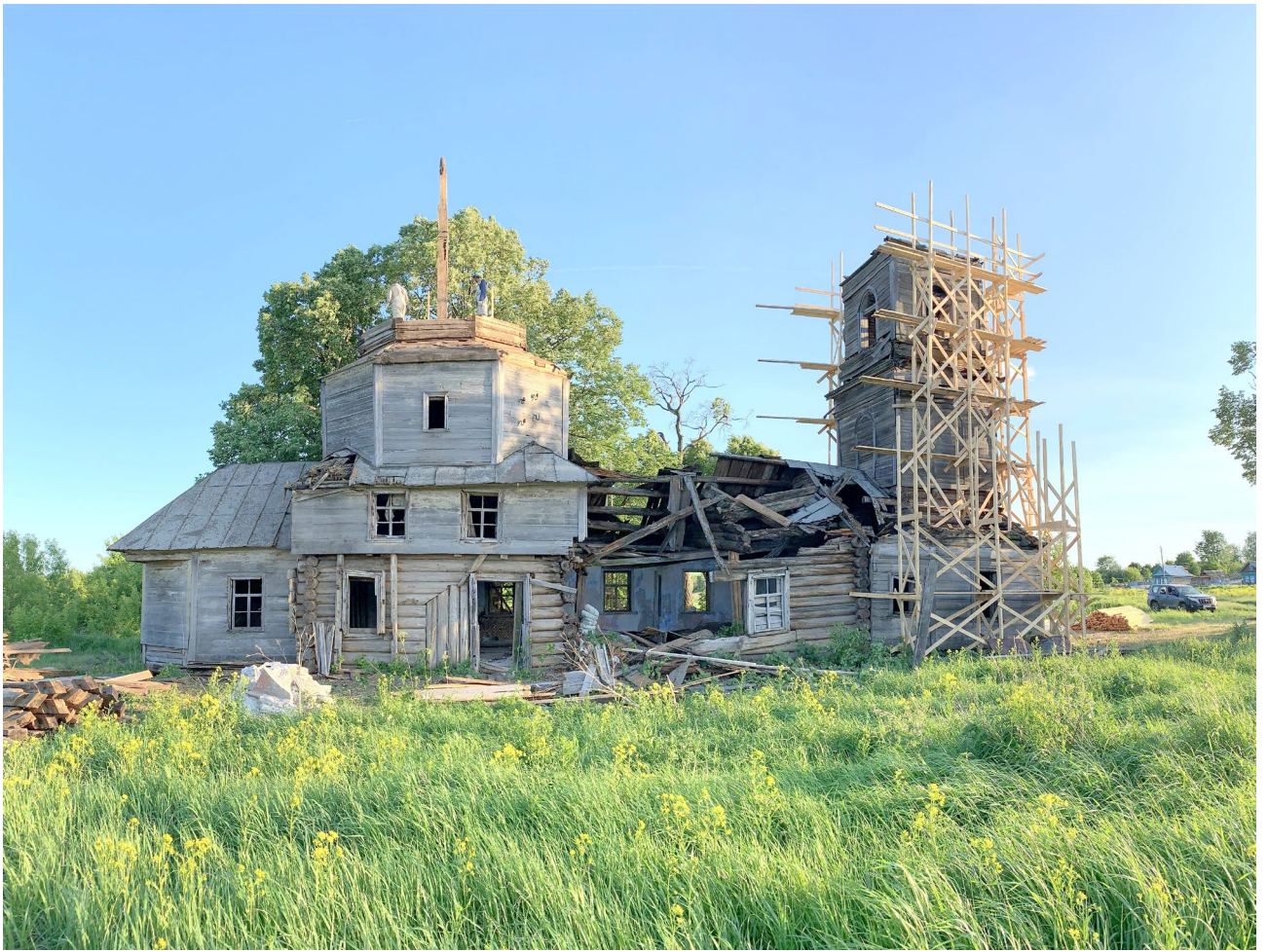
Илл. 29. Вид с севера. Разборка сруба второго восьмерика.
