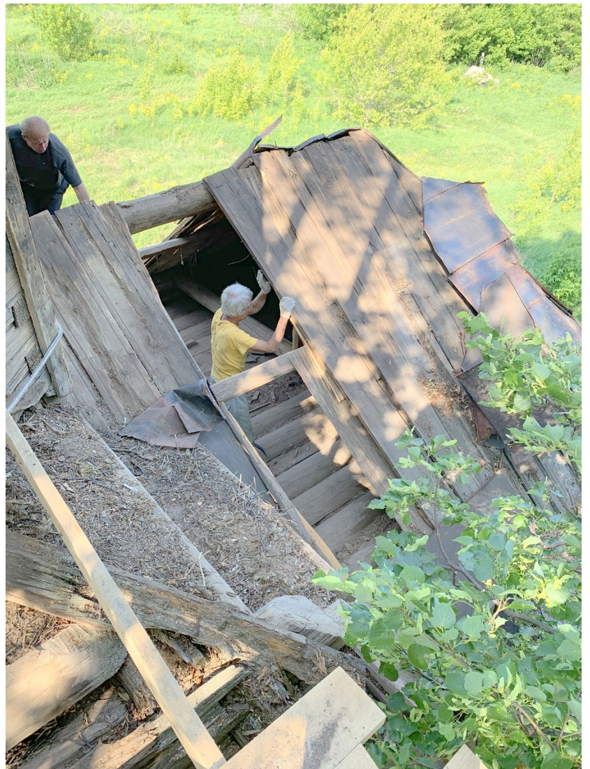
Илл. 42. Снятие вертикальной обрешетки с алтаря. Листы липовой коры в качестве гидроизоляции.
