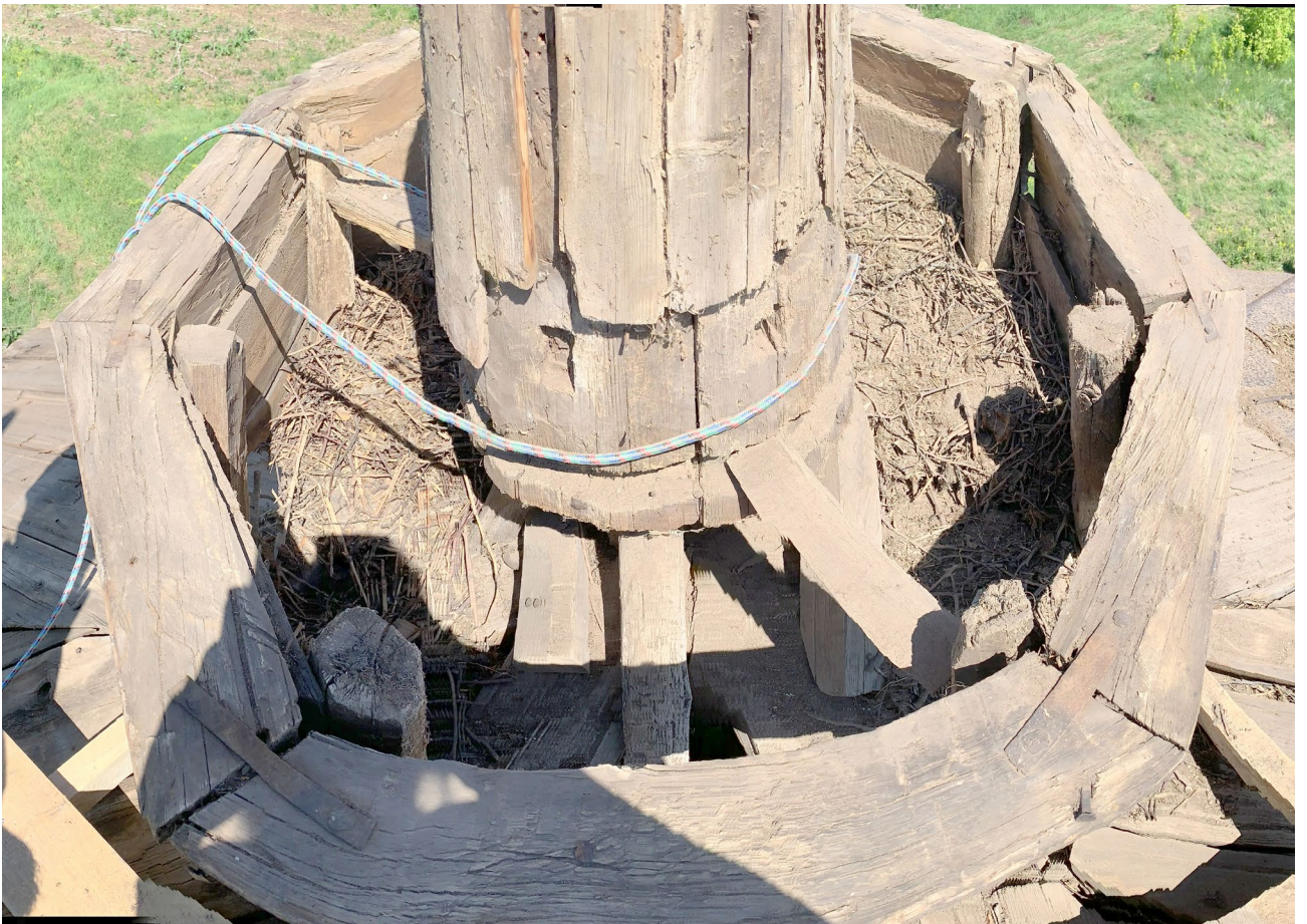
Илл. 24. Конструкция третьего восьмерика. Вид сверху. Металлические крепления обвязки.
