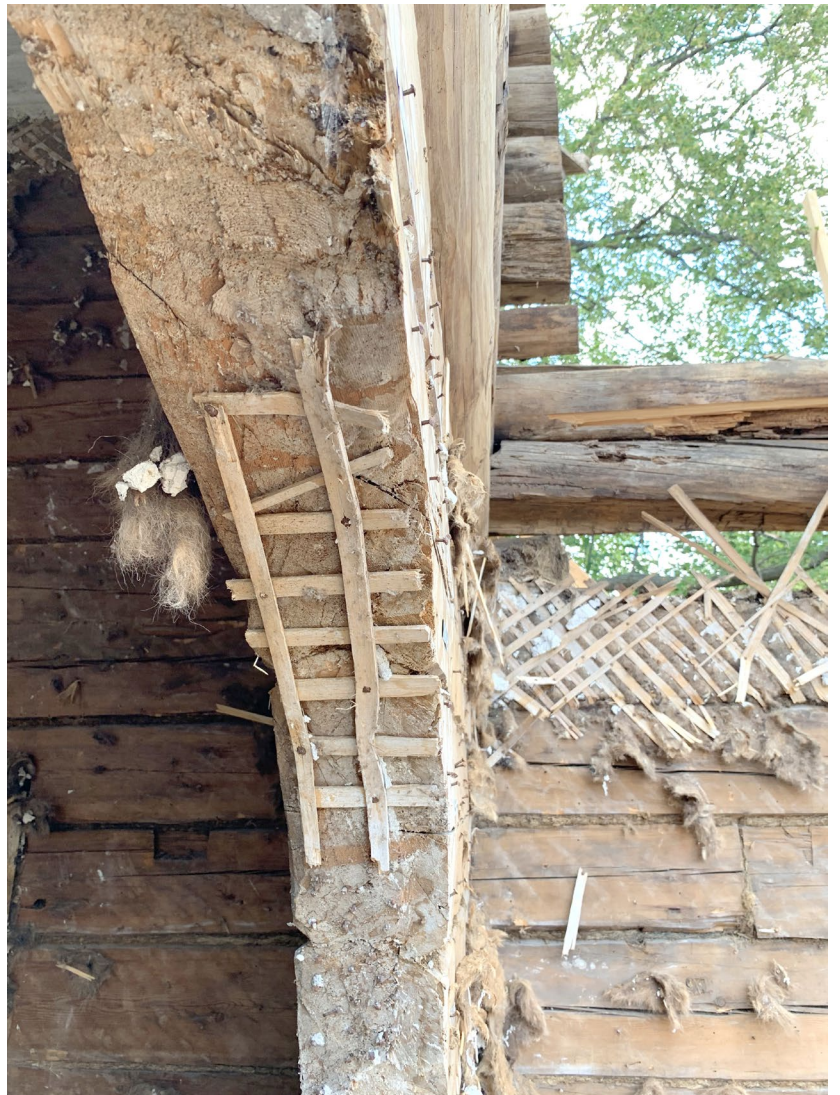
Илл. 122. Характер набивки дранки на ребре проёма между кафоликоном и трапезной.
