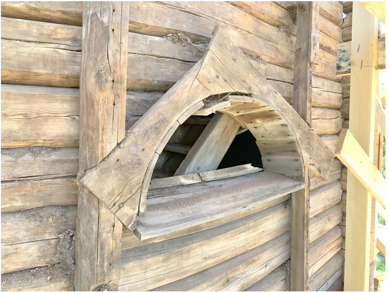
Илл. 59. Маяки и оконная коробка арочного окна на западном фасаде.
