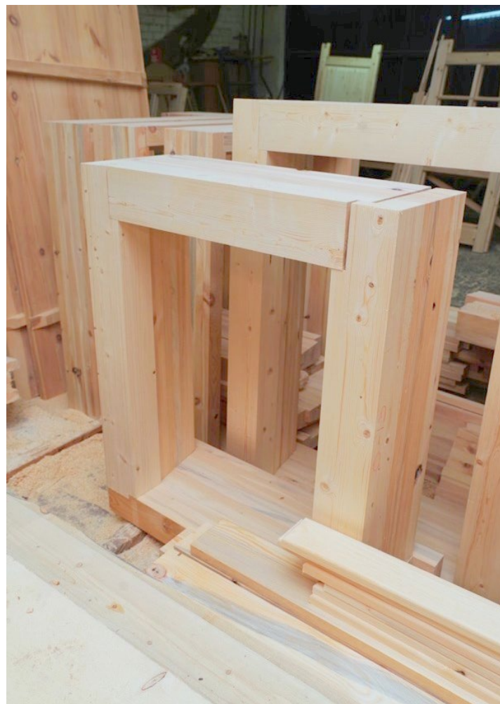
Илл. Д/8. Воссоздание оконных коробок.
