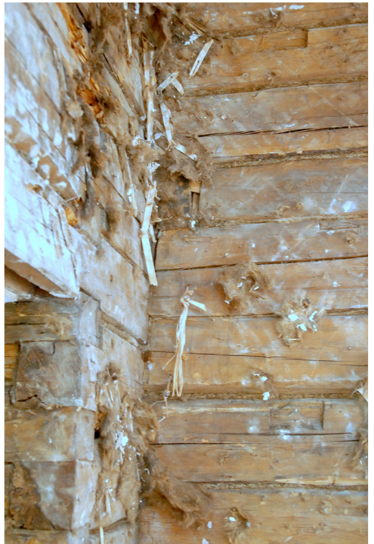
Илл. 135. След гнезда тябла иконостаса на северной стене кафоликона и забитая штроба для завода тябла.
