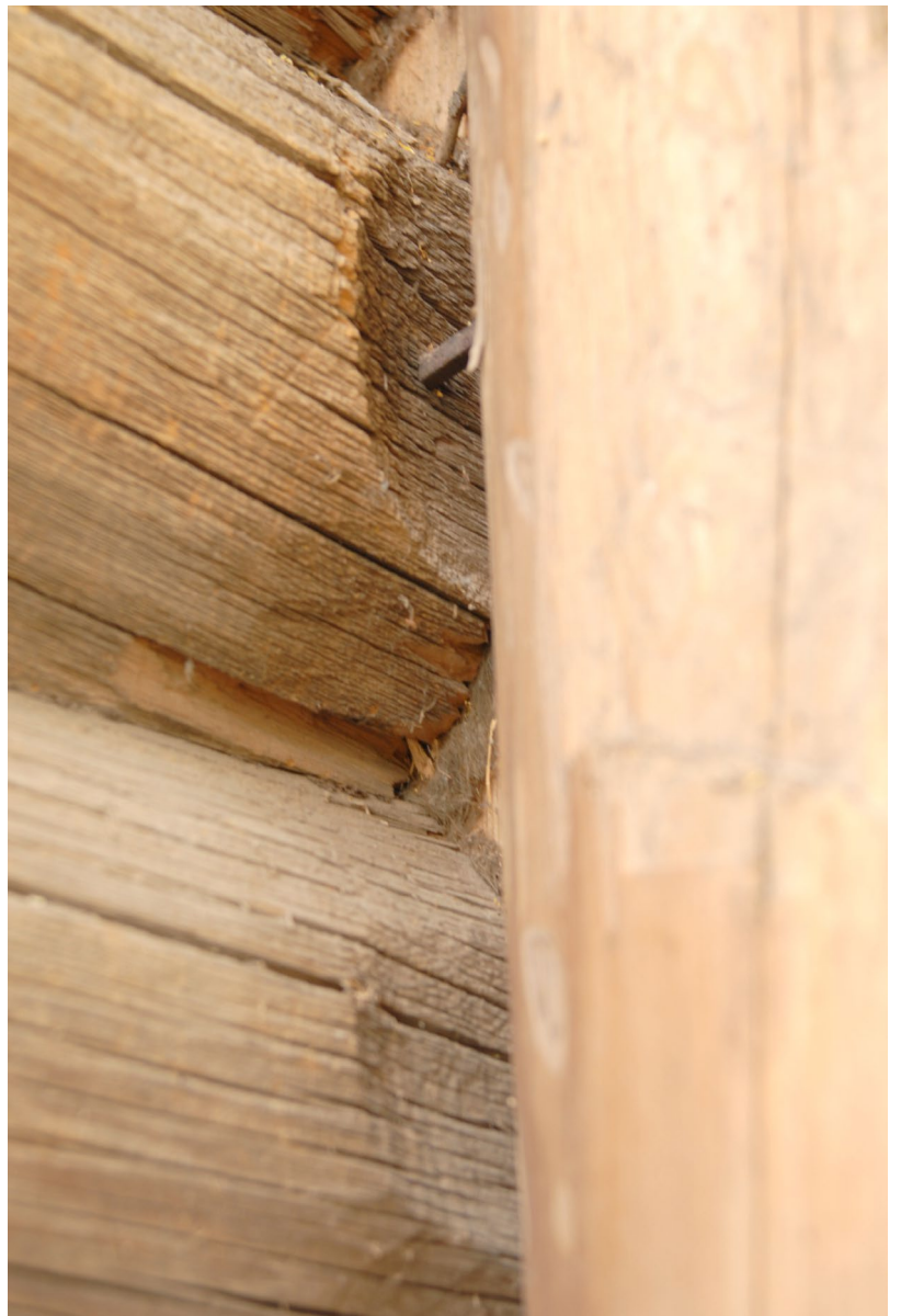
Илл. 151. Прорубленное насквозь гнездо кровли галереи-паперти XVIII в.
