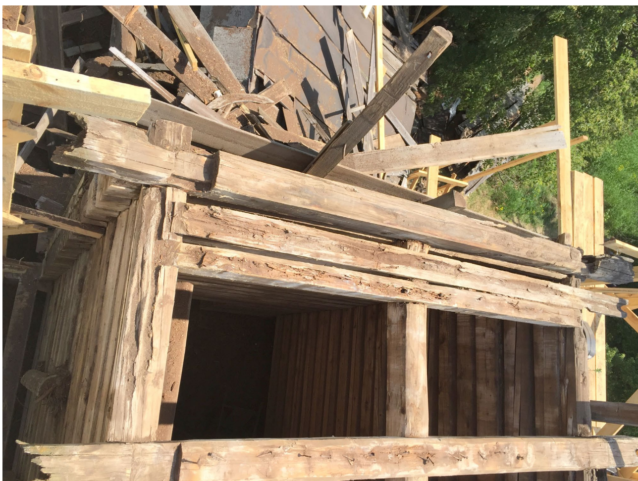
Илл. 74. Конструкция пола яруса звона колокольни. Желоб водосброса установленный под углом к срубу для защиты юго-восточного угла.
