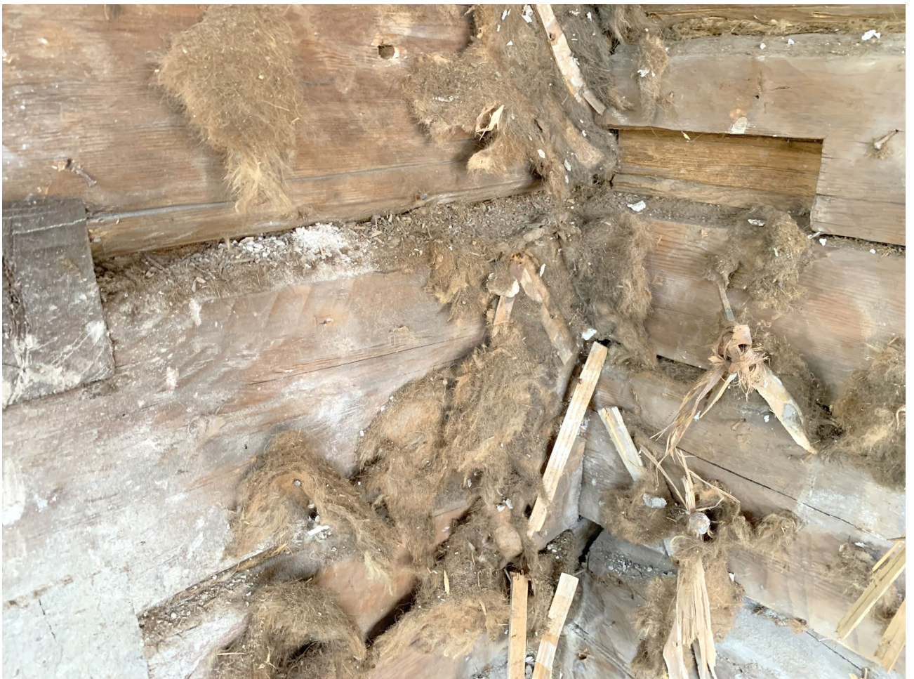
Илл. 126. Следы церковной утвари в объёме алтаря.
