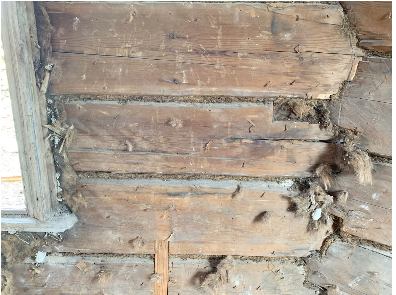
Илл. 129. Следы церковной утвари в объёме алтаря.
