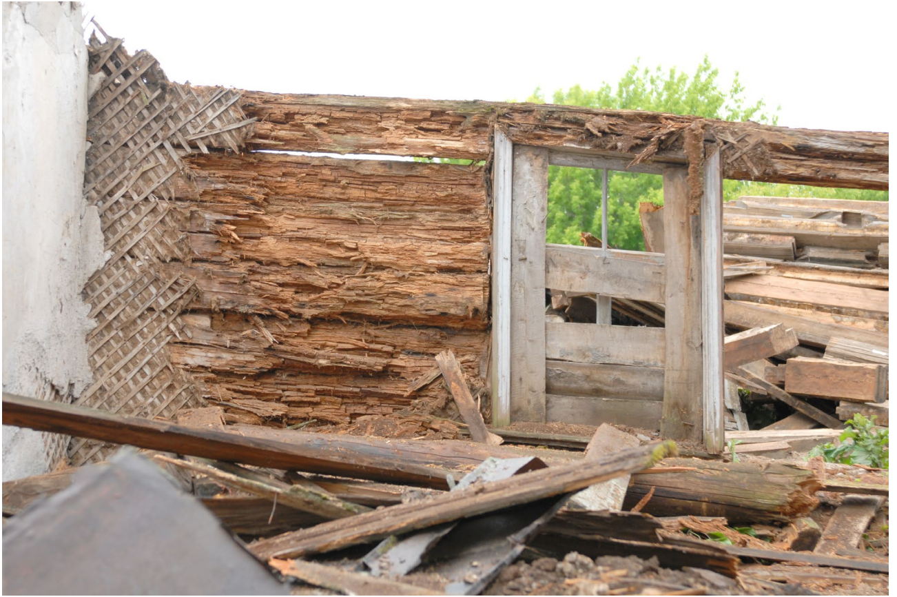
Илл. 91. Состояние сруба северной стены трапезной.
