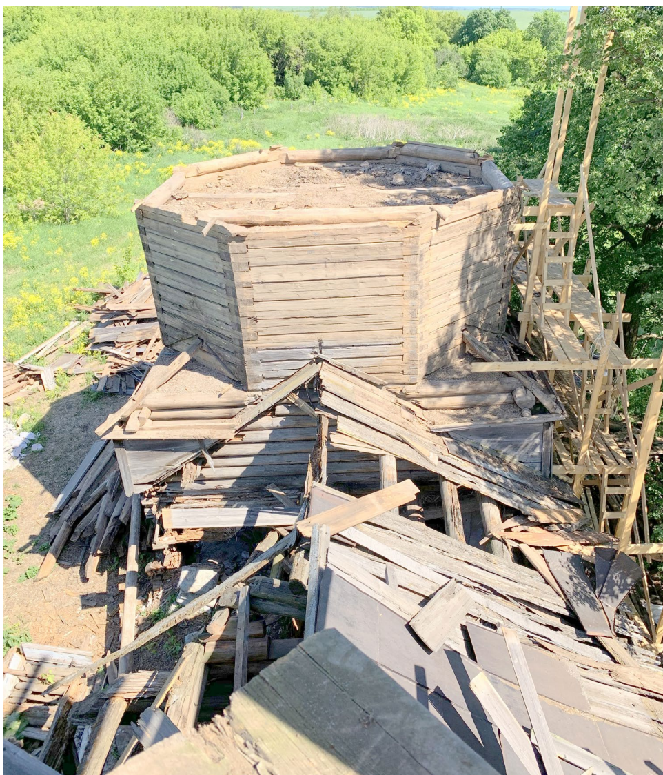
Илл. 97. Вид с запада на первый восьмерик. Стадия маркировки потолка первого восьмерика.
