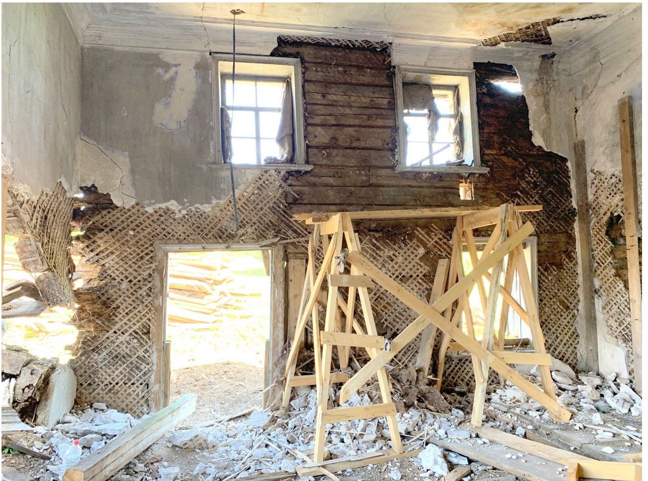
Илл. 100. Сбивка штукатурки в объём кафоликона.
