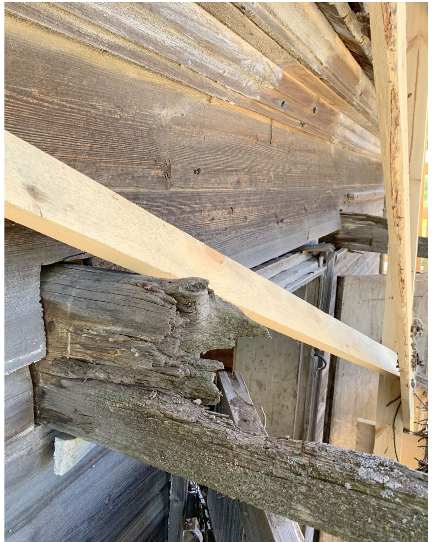
Илл. 58. Выпуски кровли крыльца.
