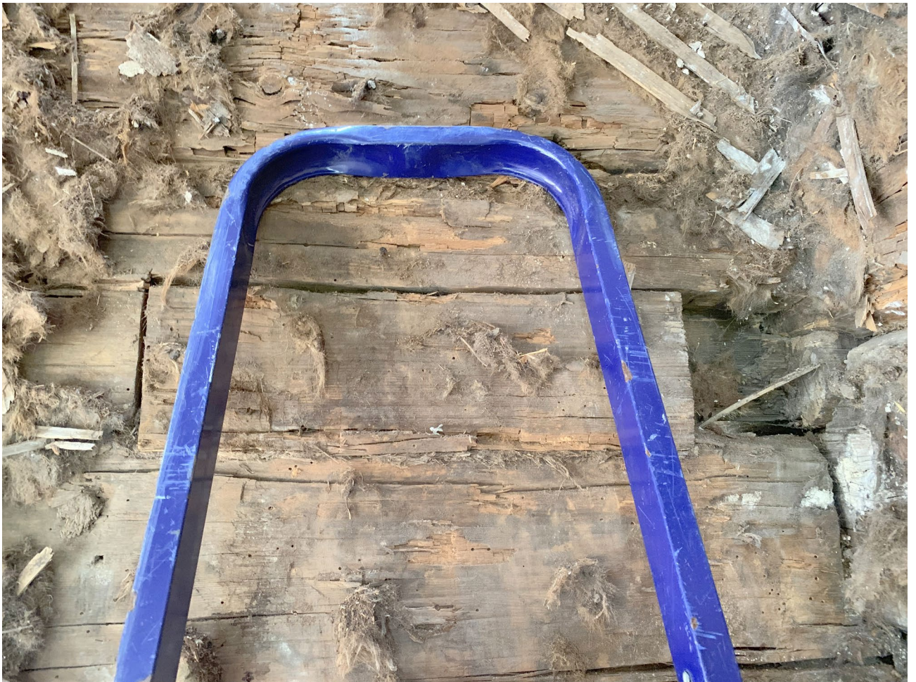
Илл. 135. След гнезда тябла иконостаса на северной стене кафоликона и забитая штроба для завода тябла.
