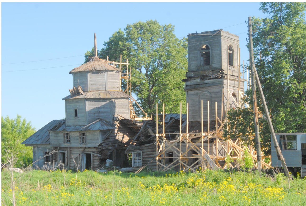
Илл. 4. Вид с северо-запада на стадии снятия покрытия кровли второго восьмерика.
